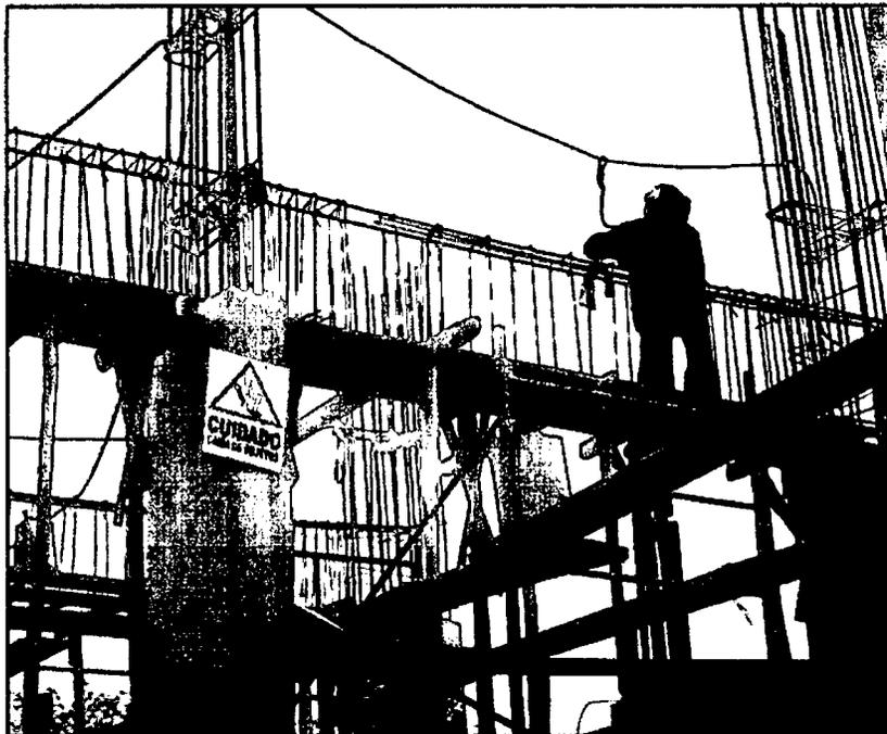
**Foto N°05:** Se observa que el trabajador se encuentra sujeto a una línea de vida con su arnés, pero sin embargo los puntos de anclaje del arnés no son lo suficientemente resistente para su peso.
