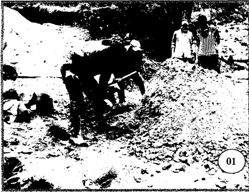
**Foto N° 01:** Manipulación de mezclado de concreto manualmente, lo cual a va demandar más esfuerzo para esta actividad tomándose un tiempo de descanso. Cómo se puede ver en la foto
