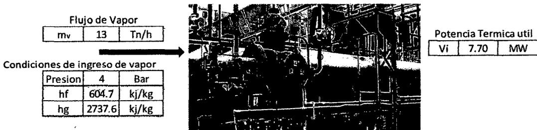
**Figura N°36 Determinación de Potencia Térmica Útil en Cocinadores**
