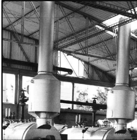
Figura N° 28 Trampa usada para economizadores
