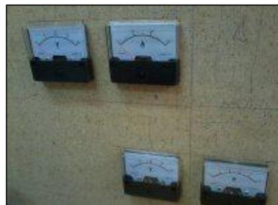
**Figura 50** Voltímetro y Amperímetro DC.
