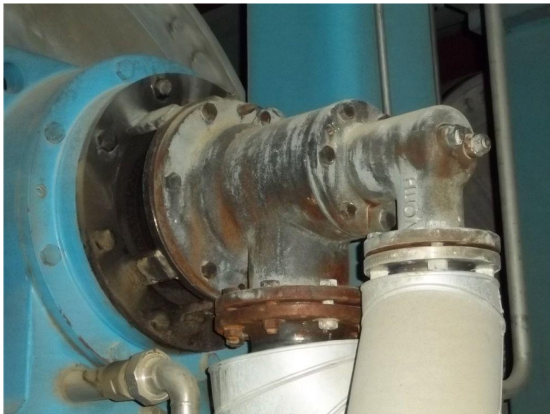
Figura N°10 Junta Johnson para el suministro de vapor de Secador Rotadiscos
