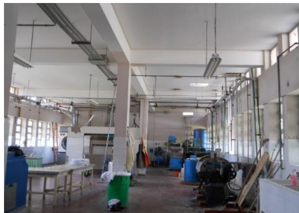
Figura N° 27: Servicio de Lavandería.
