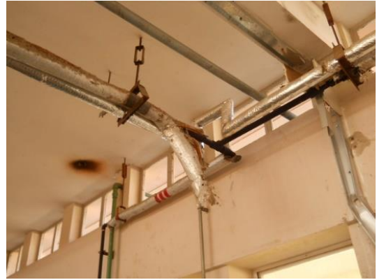
Aislamiento deteriorado por falta de enchaquetado y tiempo de uso.
