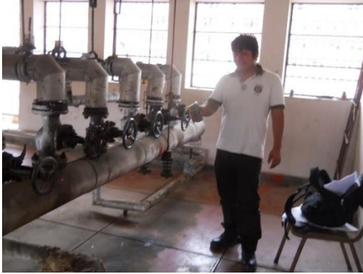
Medición de temperatura superficial en tuberías.
