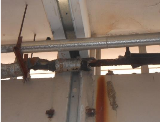
Aislamiento deteriorado por falta de enchaquetado y tiempo de uso.
