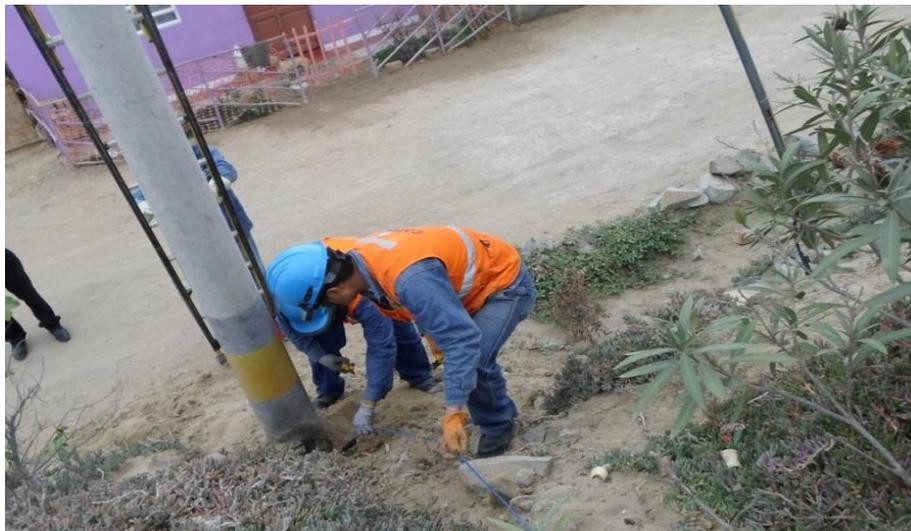
**Conexiones clandestinas llevadas en forma subterránea con alambre telefónico en zonas de hurto masivo.**
