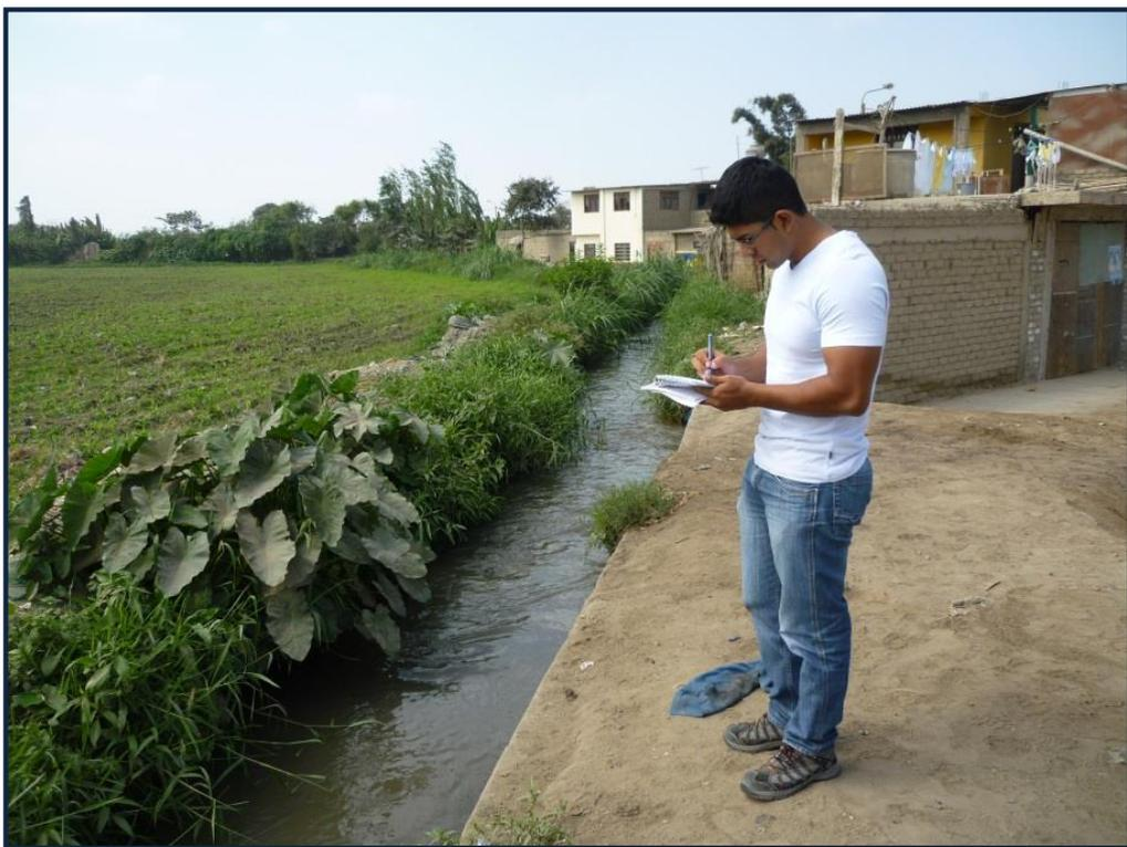
**Foto 16:** Canal revestido de sección transversal rectangular de 1.50x0.60 m – progresiva 0+560
