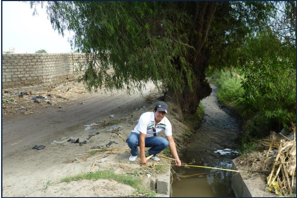
**Foto 11:** Sección de canal discontinuo debido a la falta de revestimiento y sedimentación de las arenas
