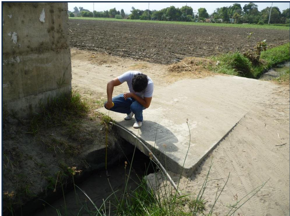
**Foto 12** En Ciertos tramos de canal los sedimentos reducen la altura del canal hasta más de un 50 %
