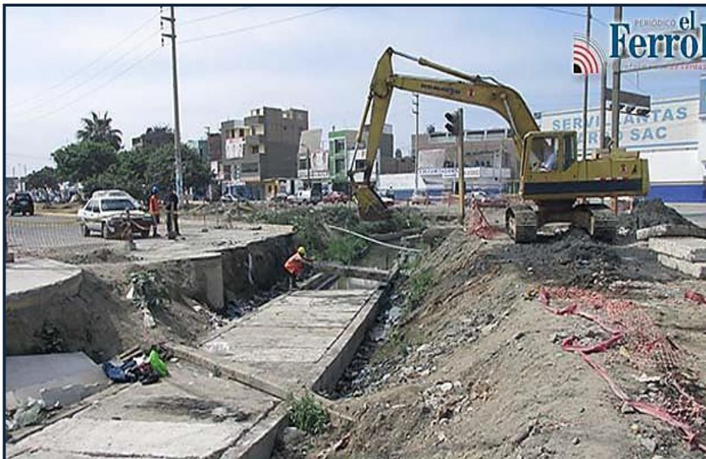
**Foto 05:** Tapado y relleno de zanja del dren de aviación en el año 2014, del cual no se levantaron observaciones hechas por el CIP y que sigue funcionando de manera deficiente hasta la fecha, año 2015.
