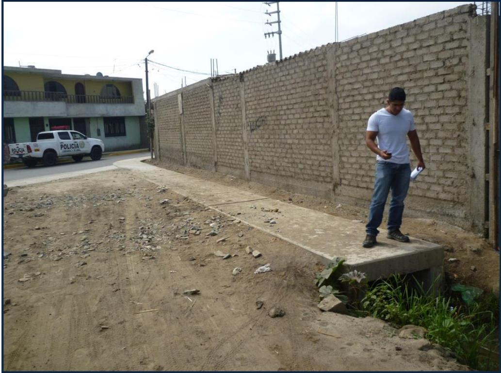
**Foto 15:** Empalme de canal rectangular tapado con canal natural sedimentado y colmatado
