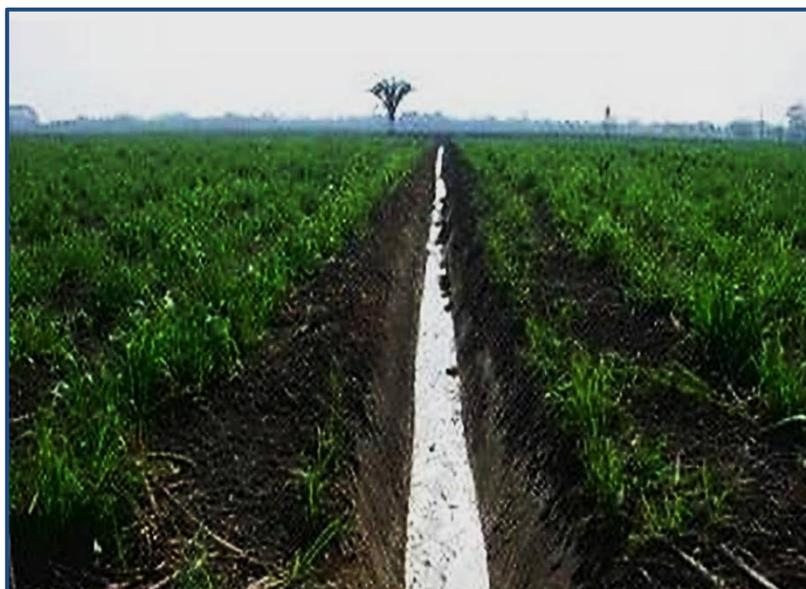
*Figura 2.2: Evacuación del exceso de agua mediante un dren superficial (canal abierto)*
