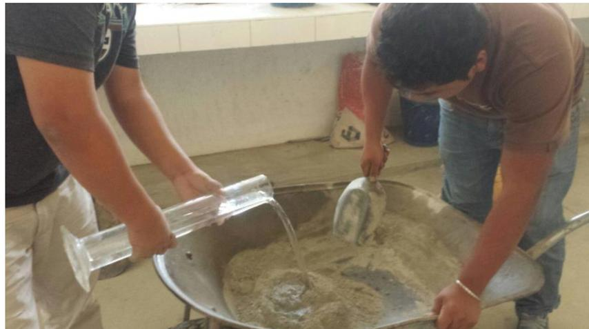
**Figura N°13 Mezclado de materiales manual**
