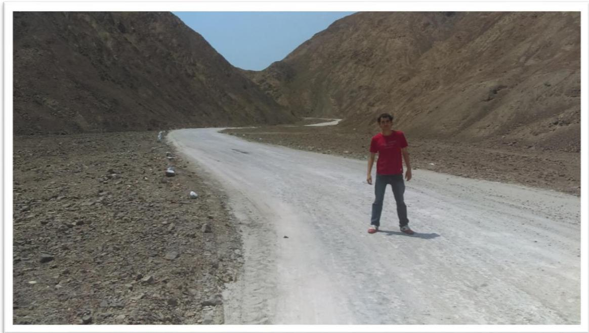
Foto N° 10: Vista de la carretera, en la que se aprecia el afirmado estabilizado con sal.
