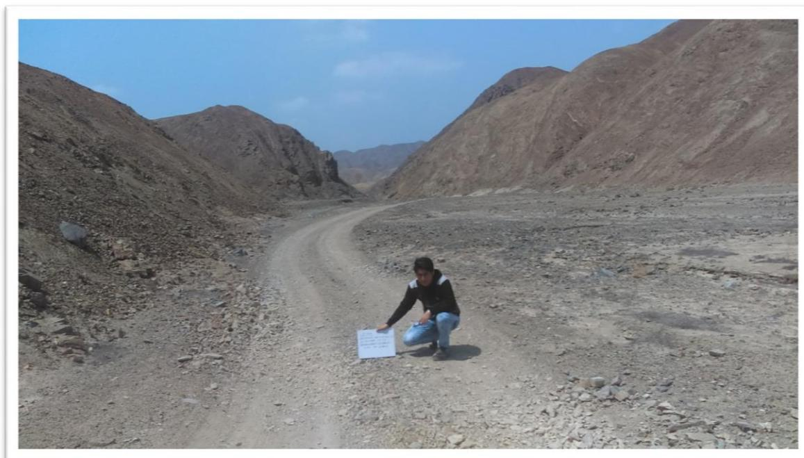
Foto N° 07: Localización de la calicata. Se aprecia la vía afirmada desgastada debido al tránsito de los vehículos.
