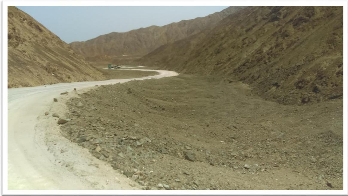
Foto N° 09: Otro sector de la carretera en el que se aprecia que el afirmado ha sido estabilizado con sal.
