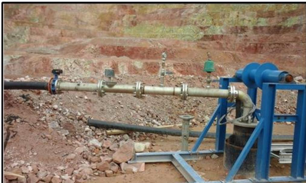
**FOTO N°6:** SE OBSERVA EL ÁRBOL DE DESCARGA DEL POZO
