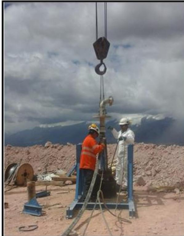
**FOTO N°5:** SE OBSERVA LA INSTALACIÓN DEL SISTEMA DE BOMBEO INTERNO DEL POZO CON AYUDA DE GRÚA.
