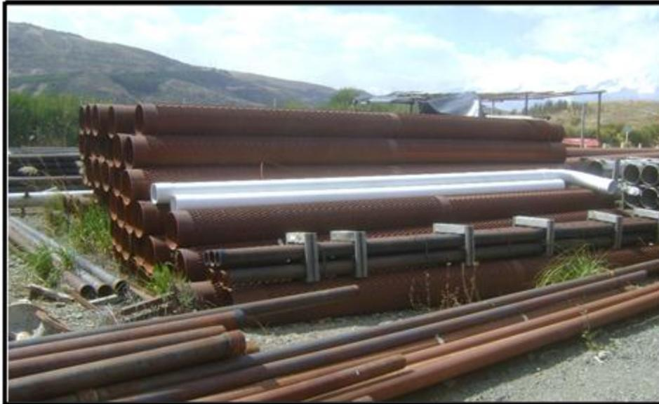
**FOTO N°3:** SE OBSERVAN LAS TUBERÍAS DE ACERO/PVC LISO Y CIEGO UTILIZADAS EN LAS ESTRUCTURA DEL POZO
