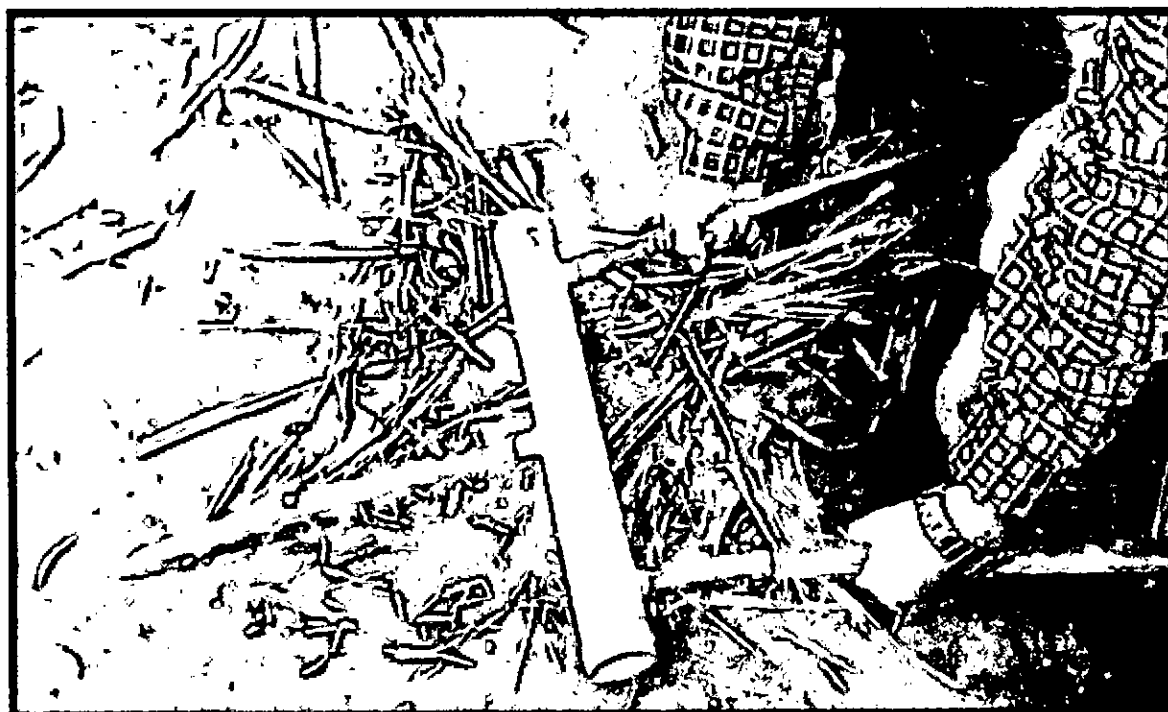
FOTO N° 16: LINEAS DE LA RED DEL SISTEMA DE RIEGO, DE AGROINDUTRIAS SAN JACINTO S.A.A
