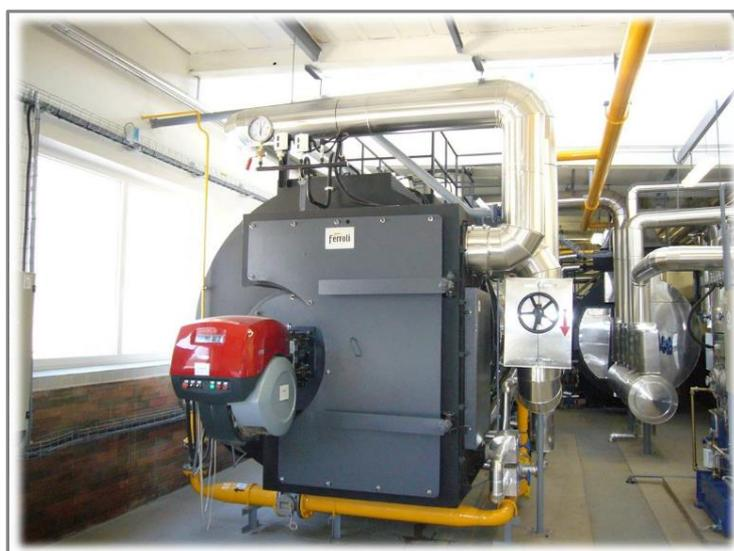
Fig. 4.18. Instalación de un quemador dual Oilon en una caldera de 500 BHP.
