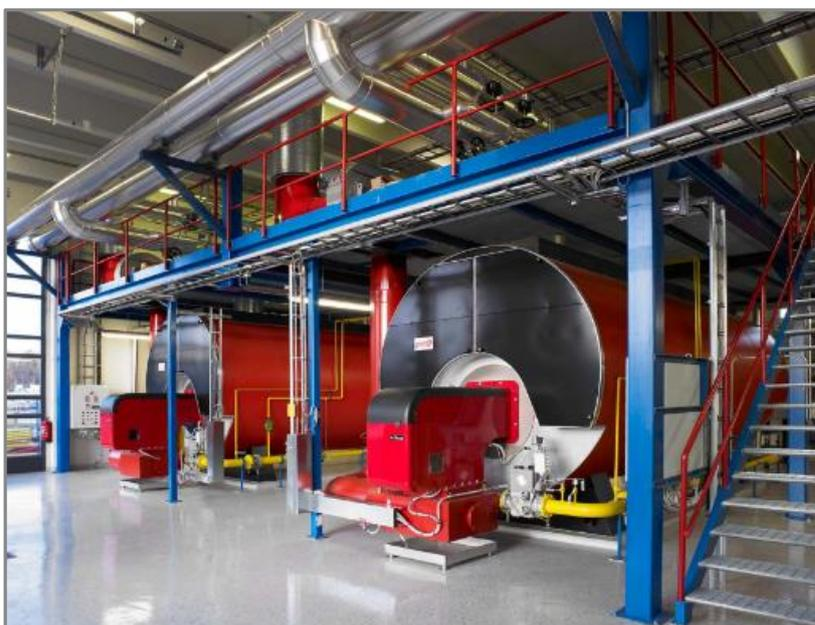
Fig. 4.19. Calderas con quemadores duales OILON.
