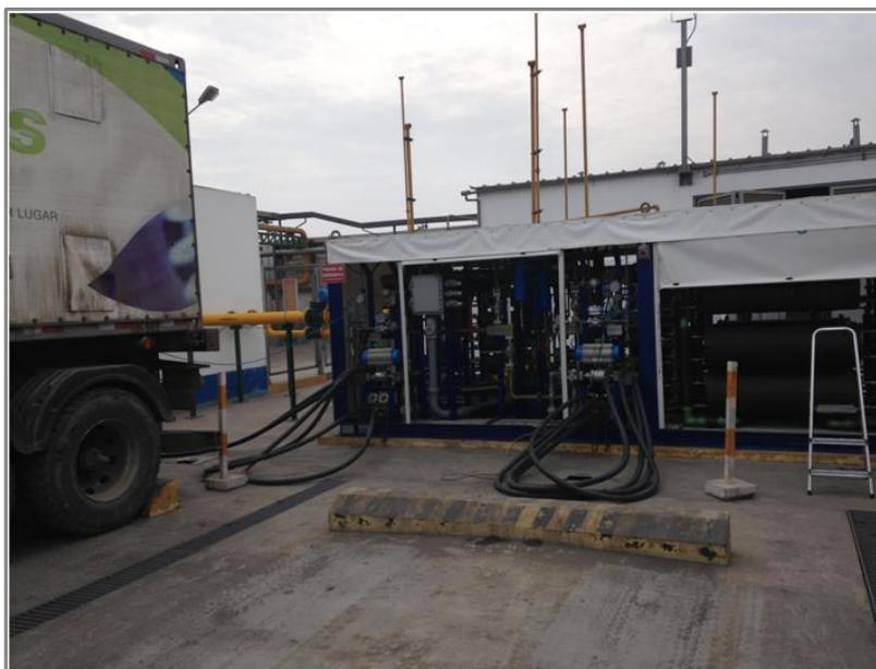
Fig. 4.12. Unidad semirremolques de GNC en la estación de descompresión
