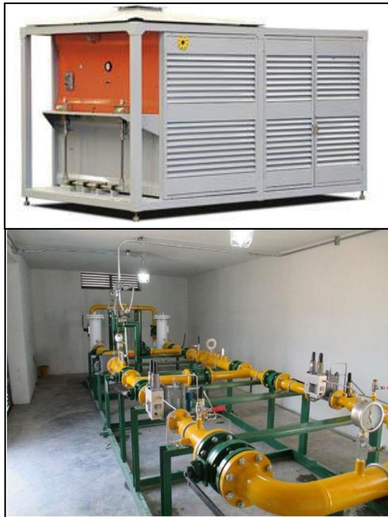
Fig. 2.19. Estación de descompresión (arriba) y estación de regulación de presión y medición – ERPM (abajo), utilizado para el sector industrial.
