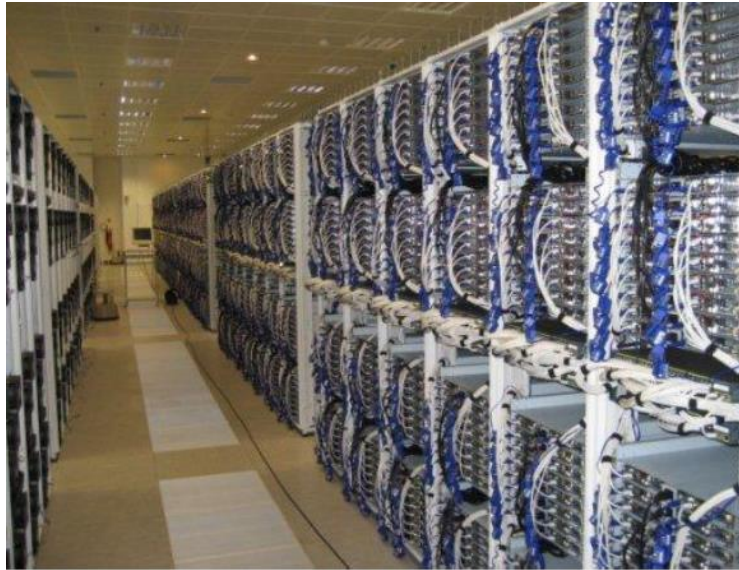
Ilustración 9: Área de distribución principal (MDA)
