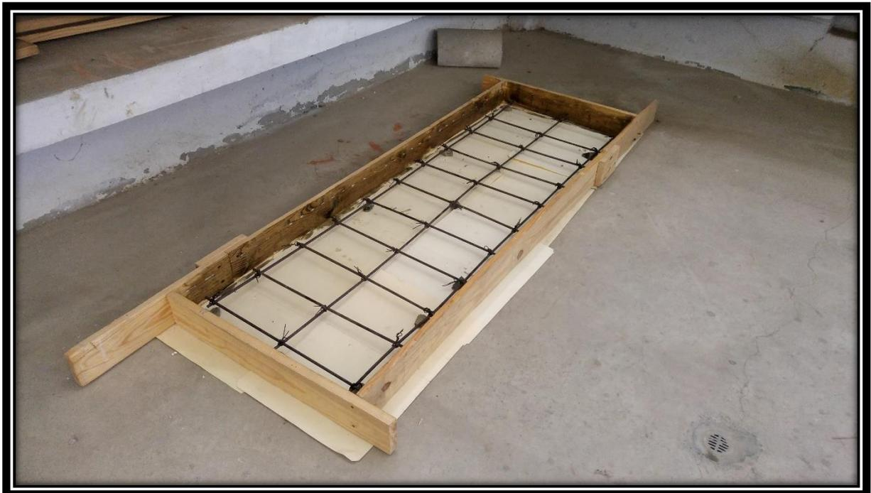
**FOTO 48:** Colocado del petróleo a las paredes del encofrado para evitar que la madera se pegue con el concreto y colocado de dados para el recubrimiento respectivo. Listo para vaciar en concreto con MEPS al 20% de adición.
