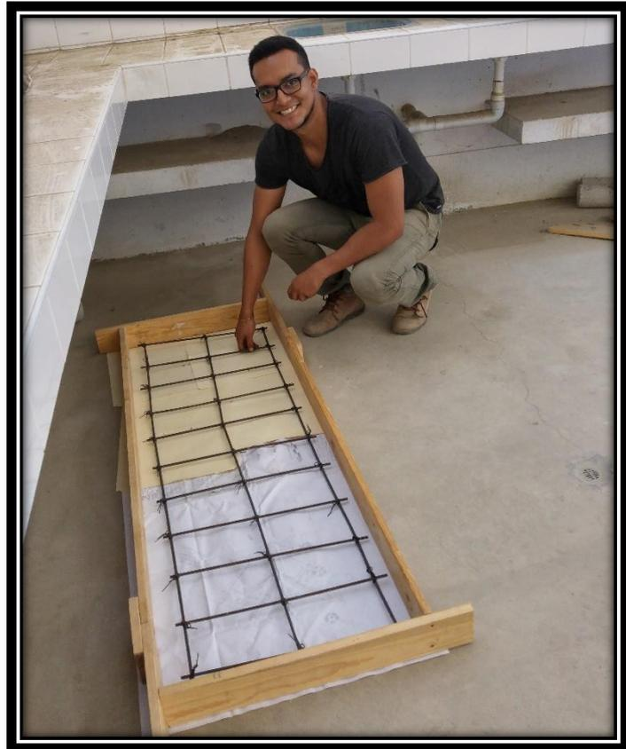
**FOTO 47:** Encofrado y colocado de la armadura de acero (6mm de diámetro) en la losa a escala 1:2.
