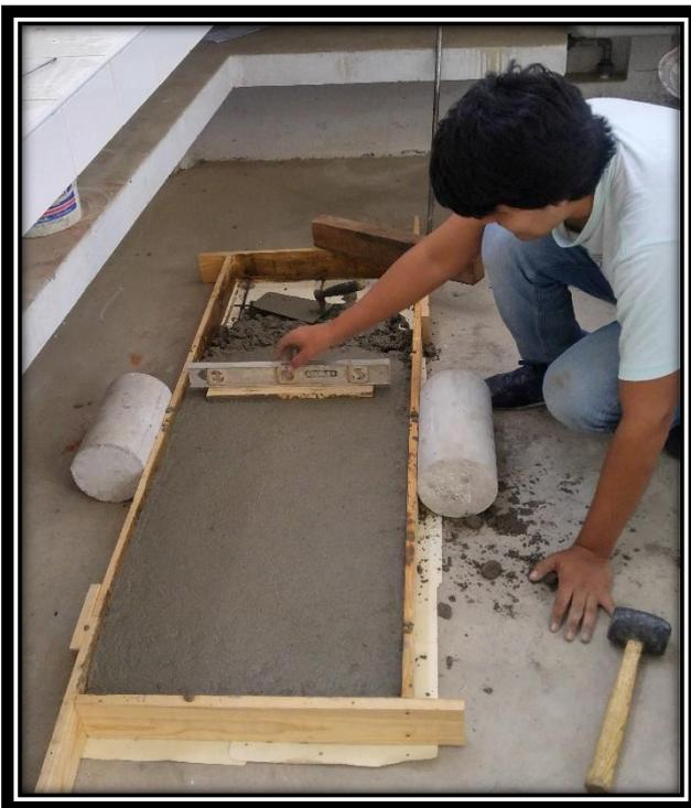
**FOTO 50:** *Vaciado y nivelado de la losa con MEPS al 20% de adición.*
