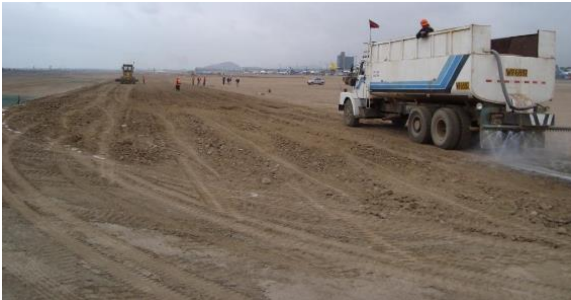
Figura 15: Aplicación de aditivo Maxx Seal 100 - Aeropuerto Internacional Jorge Chavez.
