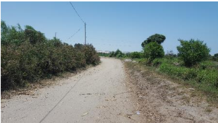
Figura 7: Presencia de desprendimiento de material.
