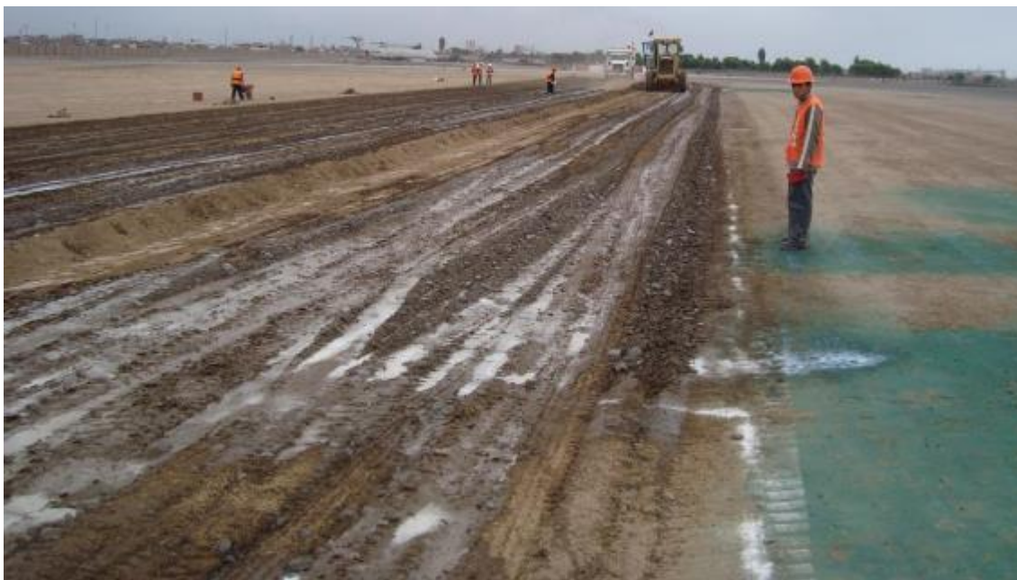
Figura 16: Vista de a aplicación de aditivo Maxx Seal 100 – Aeropuerto Internacional Jorge Chavez.
