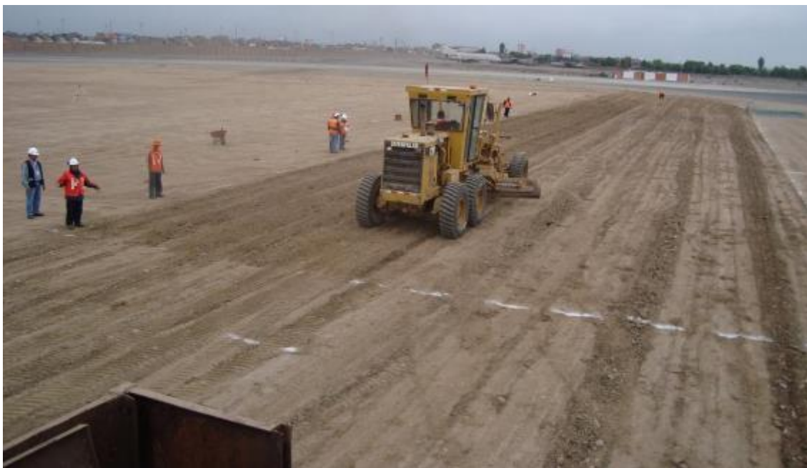
Figura 14: Batido y conformación de calzada en Aeropuerto Internacional Jorge Chavez.
