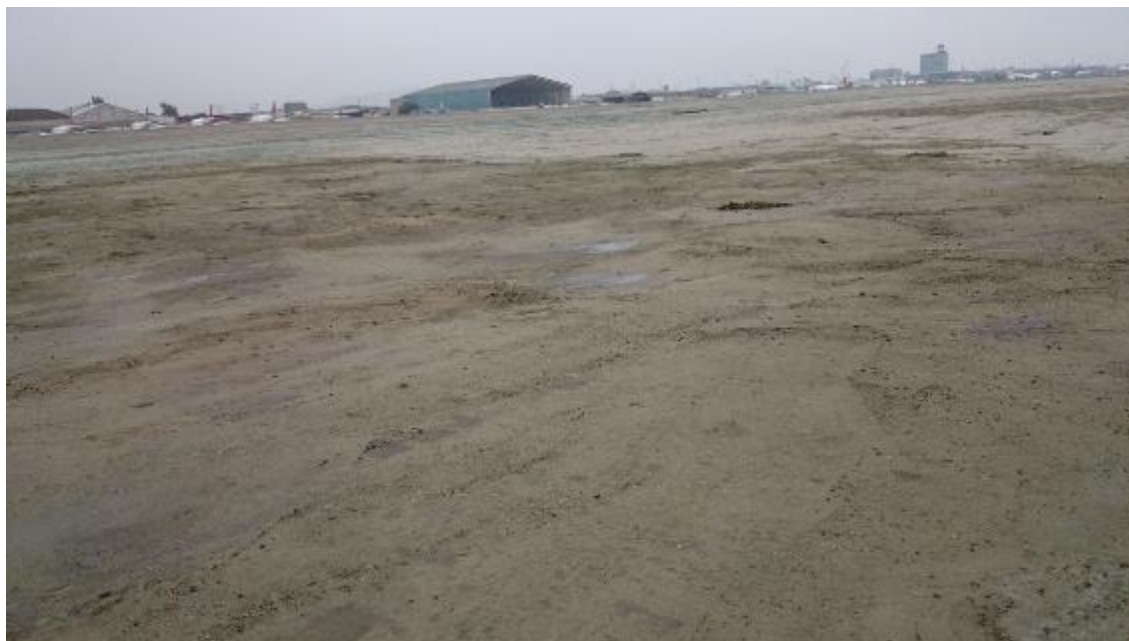
Figura 18: Vista del secado de la aplicación tópica - Maxx Seal 100 – Aeropuerto Internacional Jorge Chavez.
