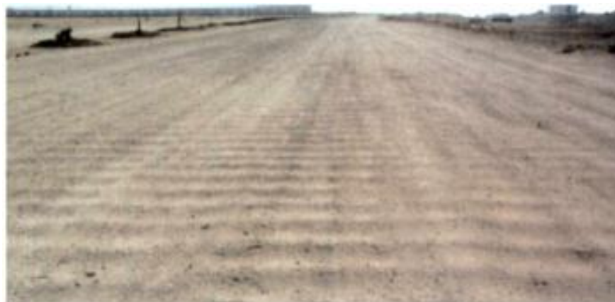
Figura 12: Calzada encalaminada < 5 cm.
