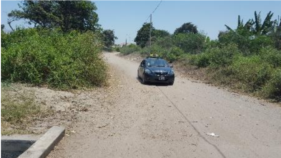
Figura 6: Presencia de desprendimiento de material.
