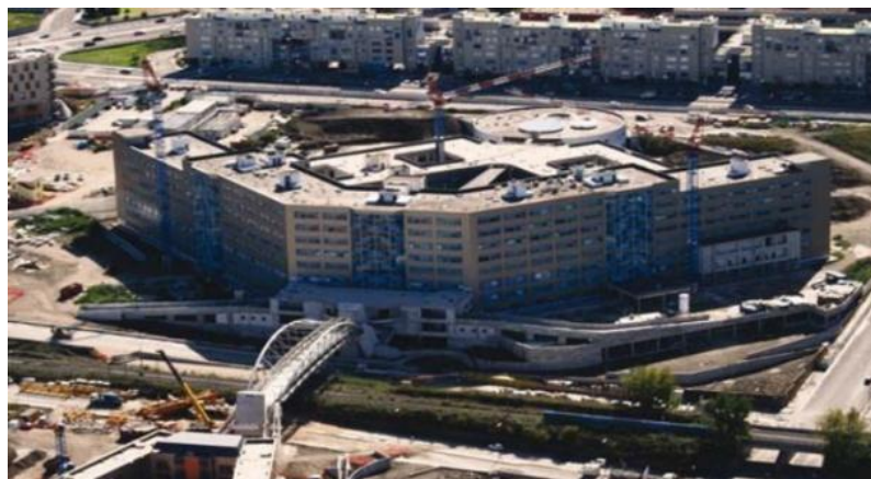
Figura 8. Hospital Ospedale del Mare, Nápoles.
