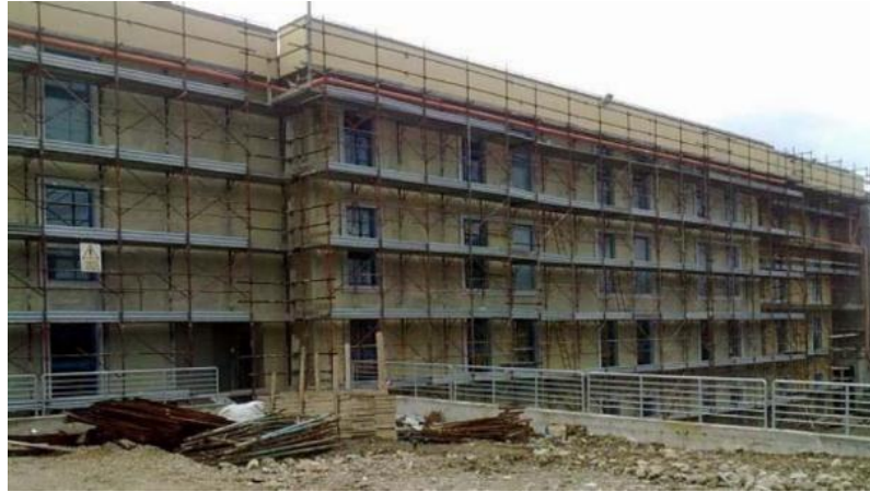
Figura 9. Modernización de hospital, Avellino.
