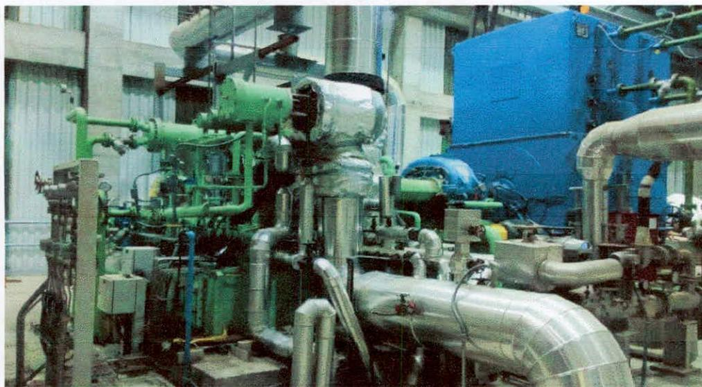
**N° 2:** Turbogenerador de 7.5 Mw, (Turbina: TGM; Reductor: Renzanini y Generador: WEG)
