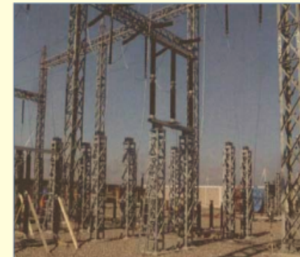
Vista de montaje de polos de seccionador tripolar 220 kV
