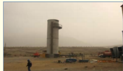
Quemador de Biogás
