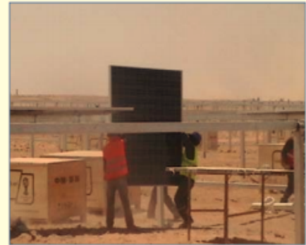
Instalación de Módulos Fotovoltaicos
