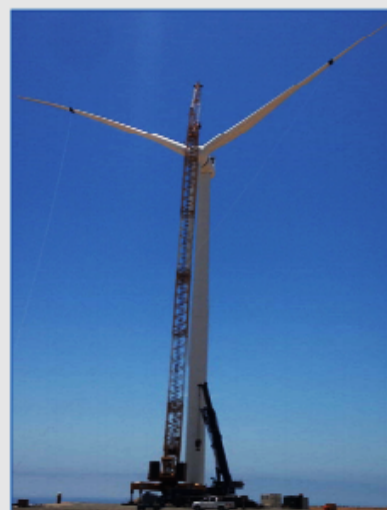
Montaje de Palas
