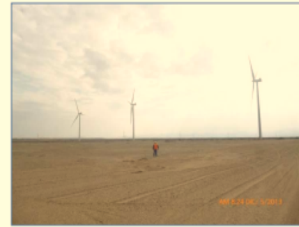
Vista de los aerogeneradores montados
