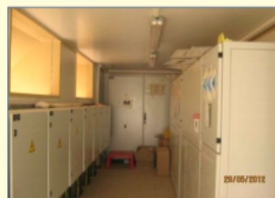
Centro de Transformación de Corriente Continua a Corriente Alterna
