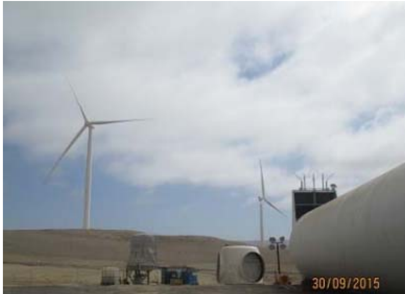
Figura N° 8 Central Eólica Tres Hermanas 90 MW
