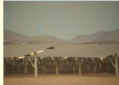
Instalación de Módulos Fotovoltaicos
