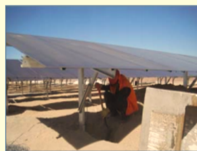
Disposición Final de Módulos Fotovoltaicos
