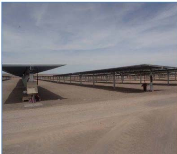
Figura N°16 Instalación de Estructuras y paneles solares Central Solar Rubí
