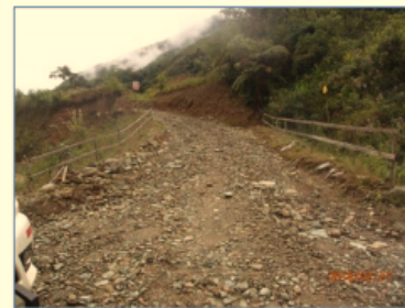
Camino de acceso a Cámara de Carga (tramo 1)
