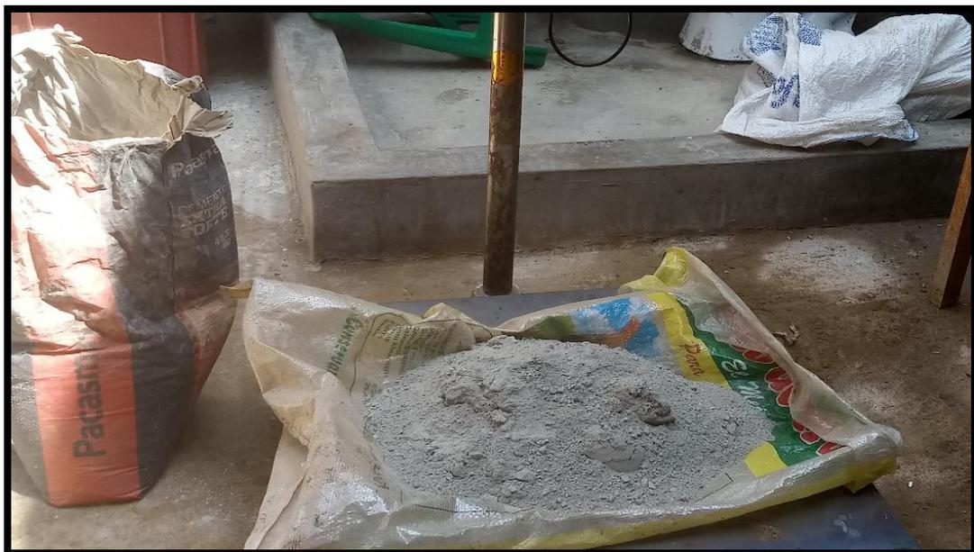
*Descripción: Pesaje del cemento, para la adición a la mezcla y la posterior fabricación de unidades de adobe.*
