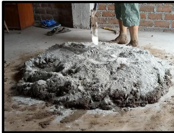
*Figura 32: Mezclado del suelo con aditivo*
