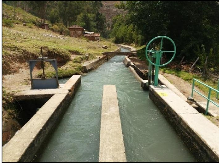
Figura N° 12 Canal de aducción de la CH Pomabamba
