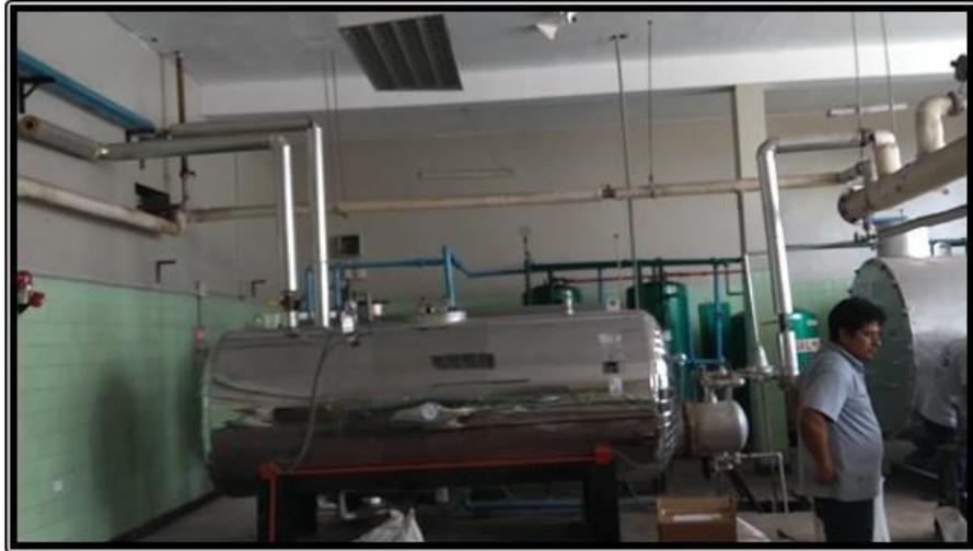
**Figura 15. Línea de vapor saturado a 100 PSI.**
