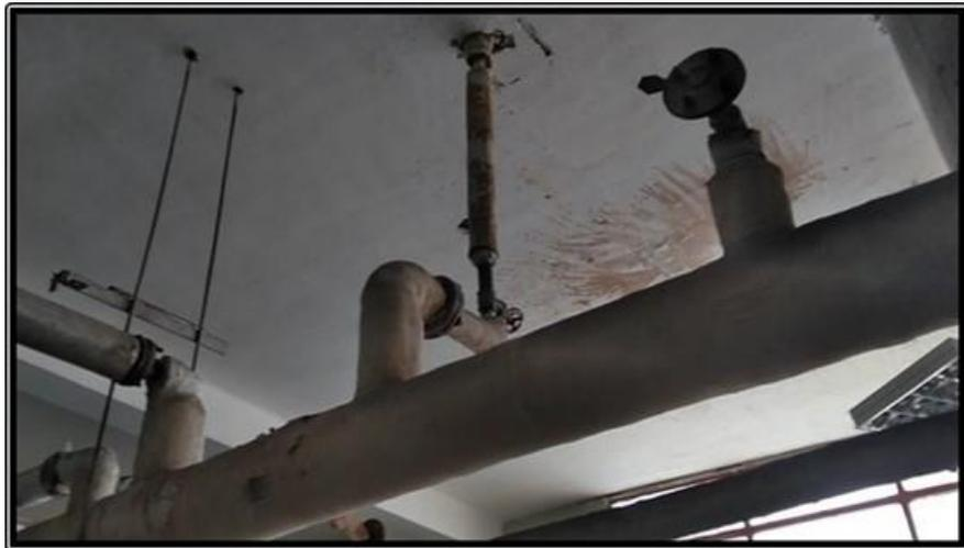
**Figura 14. Línea de vapor saturado a 50 PSI.**
