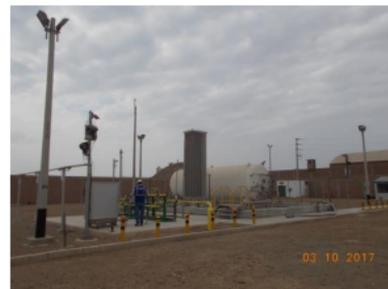
Estación de Distrito en la ciudad de Pacasmayo, vista de las instalaciones que incluye: i) Un (01) tanque de almacenamiento (30 m<sup>3</sup>), ii) Un (01) Vaporizador vertical marca THERMAX Inc y iii) Un (01) Estación de Regulación.
