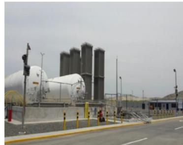
Estación de Distrito en la ciudad de Chimbote, vista de las instalaciones que incluye: i) Dos (02) tanque de almacenamiento (200 m<sup>3</sup>), ii) Seis (06) Vaporizador vertical marca THERMAX Inc y iii) Un (01) Estación de Regulación.
