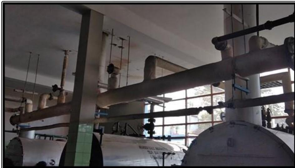
**Figura 12. Distribuidor de Vapor (Cabecero).**
