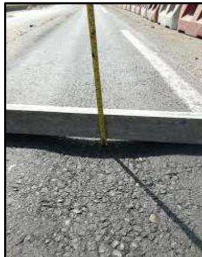
**Figura 4.** Depresión de pavimento severidad media
