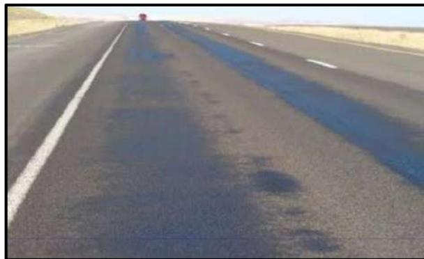
*Figura 2.* Exudación severidad alta. *Fuente:* (Corredor, 2010).
