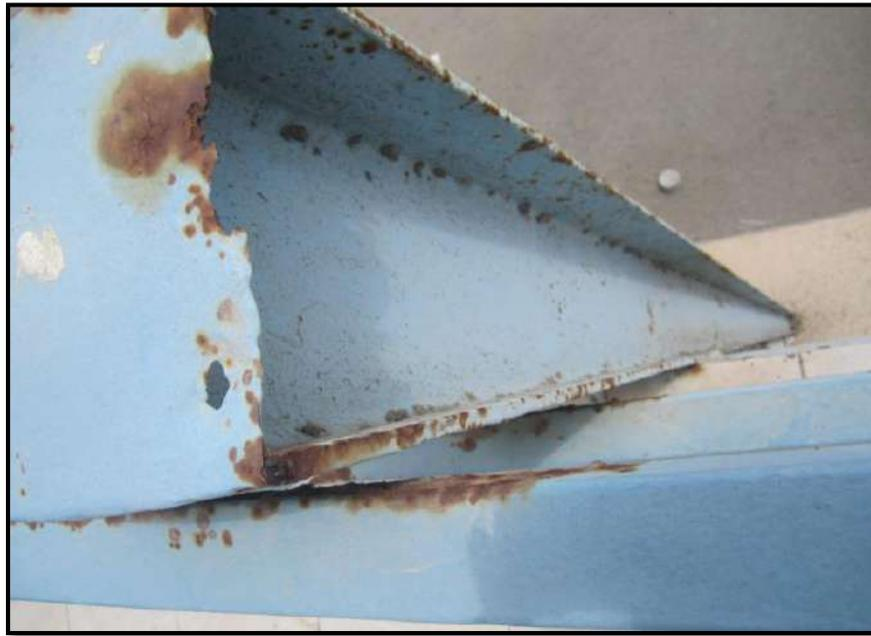
**Foto N°09.-** Vista de una columna metálica de sección H ubicada en la torre de control con presencia de corrosión de tipo uniforme a lo largo de su longitud. Cabe mencionar que este deterioro se presentó en la mayoría de estructuras metálicas de la zona de proyecto.
