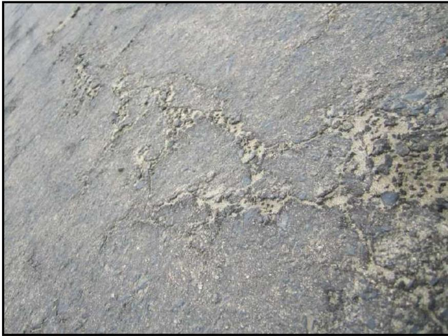
**Foto N°03.-** Vista de fallas presentadas en la pista de aterrizaje, de las cuales se tomaron medidas y fueron clasificadas según el ensayo de PCI.
