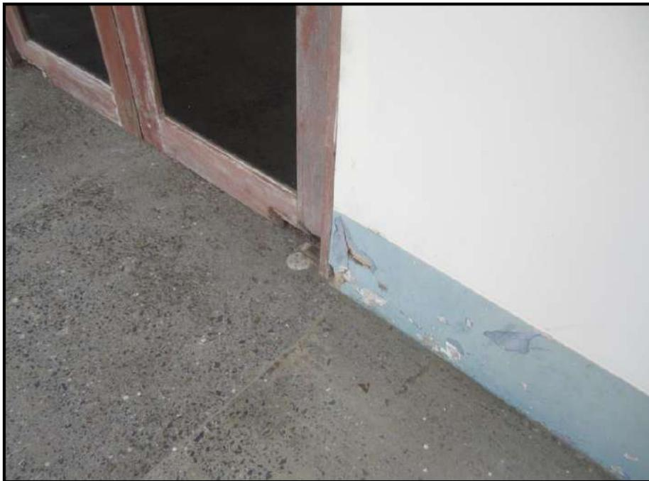
**Foto N°10.-** Vista de agrietamiento localizado y desprendimiento del tarrajeo en parte del sobrecimiento en las instalaciones del terminal de pasajeros del aeropuerto
