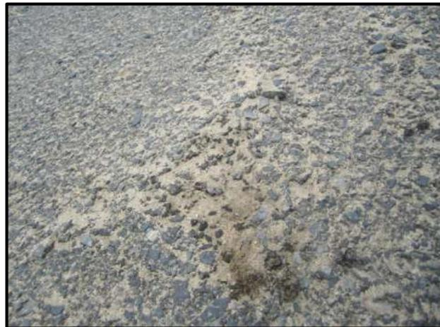
**Figura 7.** Desprendimiento de agregados.
