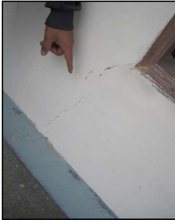
**Foto N°11.-** Se nota la presencia de fisuramiento sobre muros laterales por falta de confinamiento en vanos
