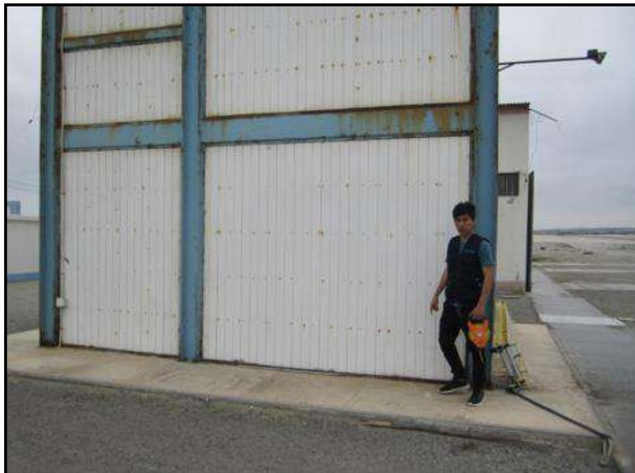
**Foto N°12.-** Vista de corrosión sobre perfiles metálicos en torre de control.
