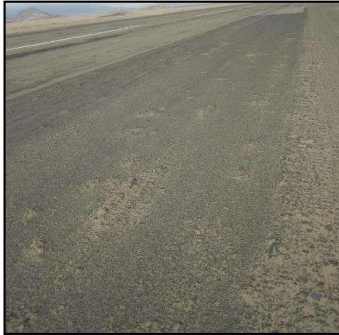
**Foto N°05.-** En la imagen se aprecia el tipo de falla denominado “potholes” o huecos según el PCI que se presentaron algunos tramos de la pista de aterrizaje.
