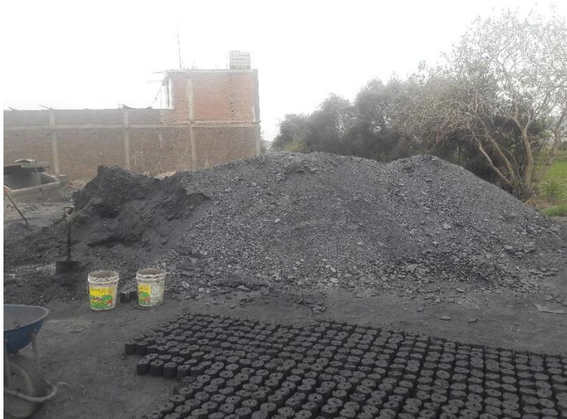
**Foto 2:** Briquetas de carbón utilizado para el cocido de los ladrillos de arcilla.
