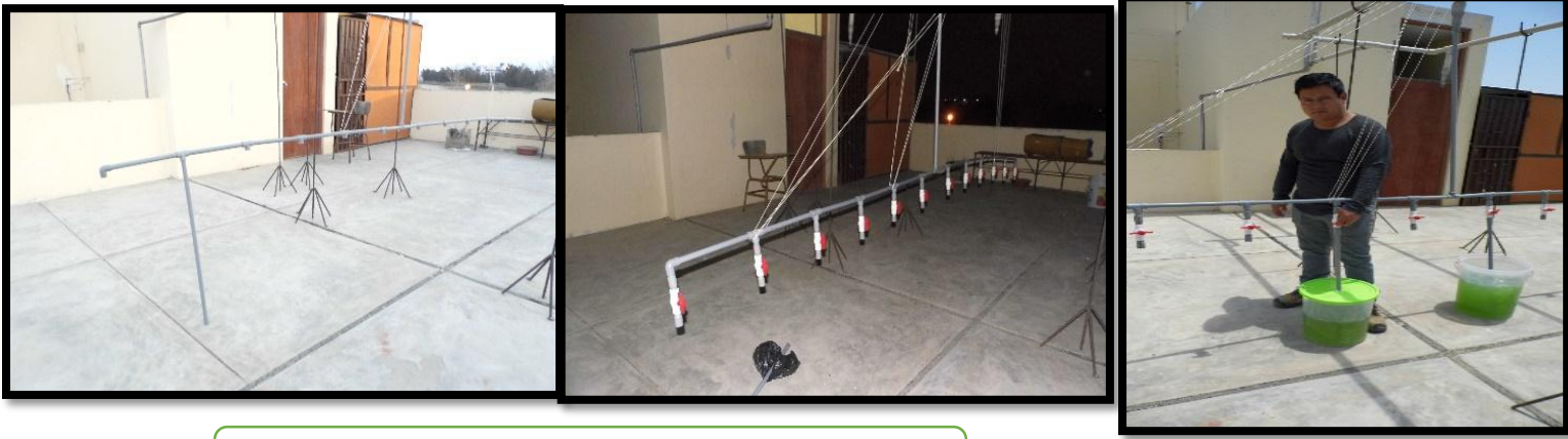
Instalación de las tuberías para la aireación
