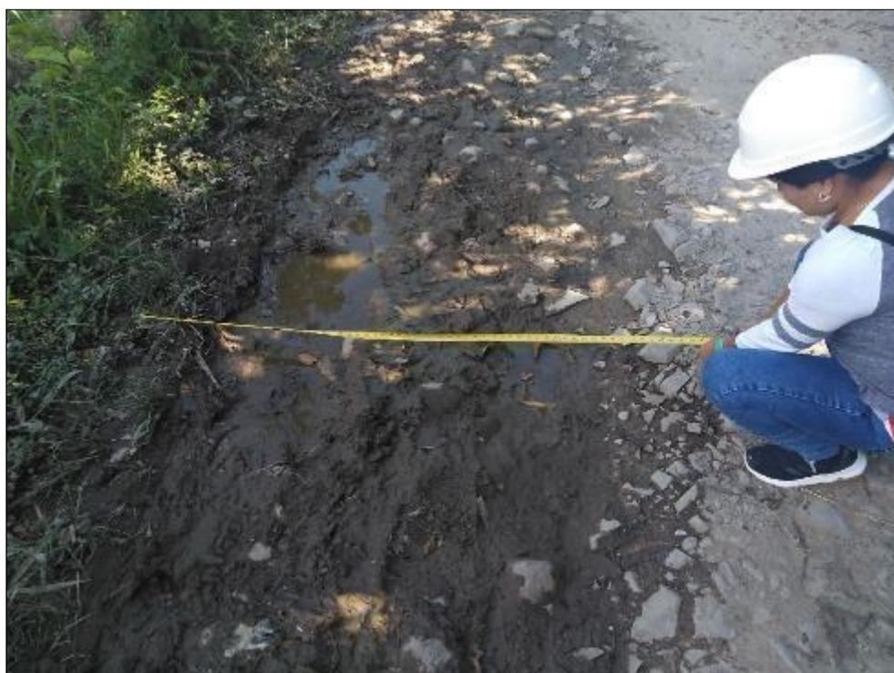
Fotografía 12. Medición de falla por lodazal – Tramo III
