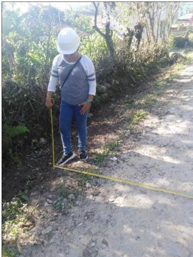
Fotografía 15. Medición de ancho de la vía en estudio – Tramo IV
