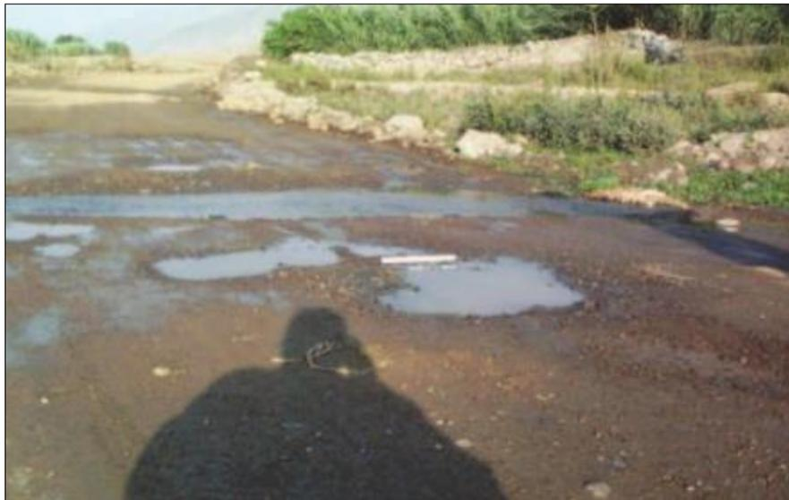
*Figura 9. Baches Gravedad III - Necesita una reconstrucción*
