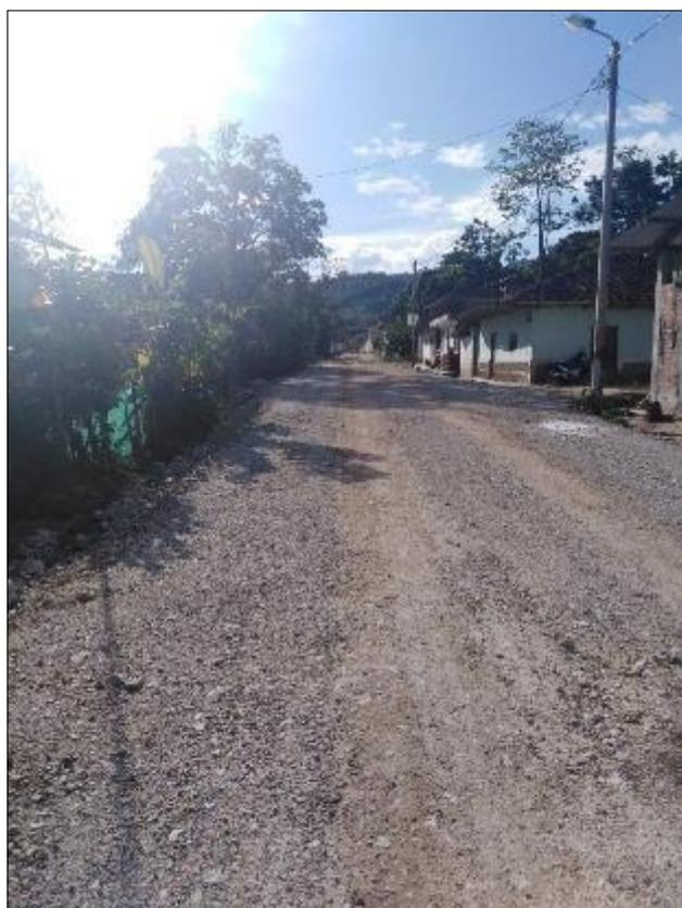
Fotografía 10. Fallas por huellas, baches y erosión – Tramo II
