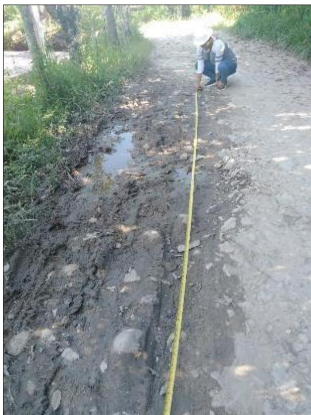
Fotografía 16. Medición de falla por lodazal – Tramo IV
