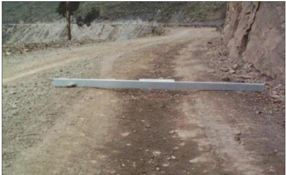
*Figura 3. Deformación Gravedad 3 - Huellas/hundimientos  $\geq 10$  cm*
