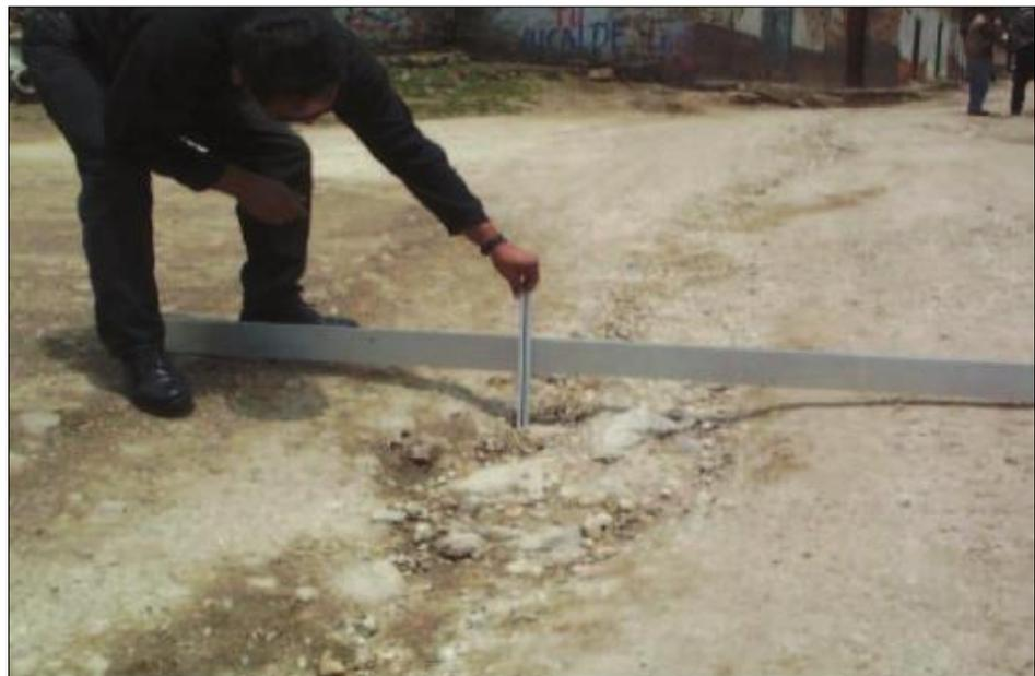
Figura 6. Erosión Gravedad III- Profundidad  $\geq 10$  cm
