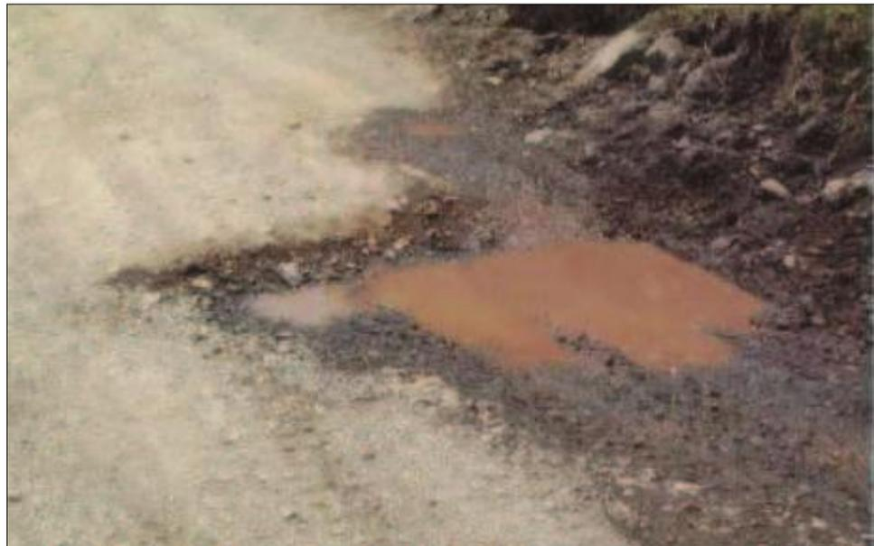
*Figura 7. Baches Gravedad 1 - Pueden repararse por mantenimiento rutinario*
