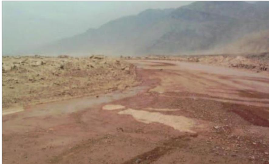
*Figura 8. Baches Gravedad II - Necesita una capa de material adicional*
