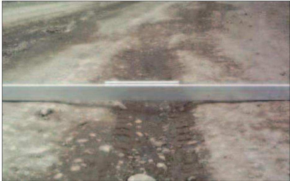
Figura 5. Erosión Gravedad II- Profundidad entre 5 cm y 10 cm
