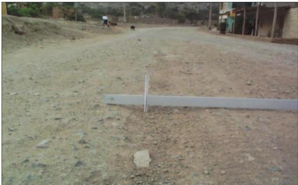
*Figura 1. Deformación Gravedad 1- Huellas/hundimientos sensibles al usuario, pero  $< 5$  cm.*
