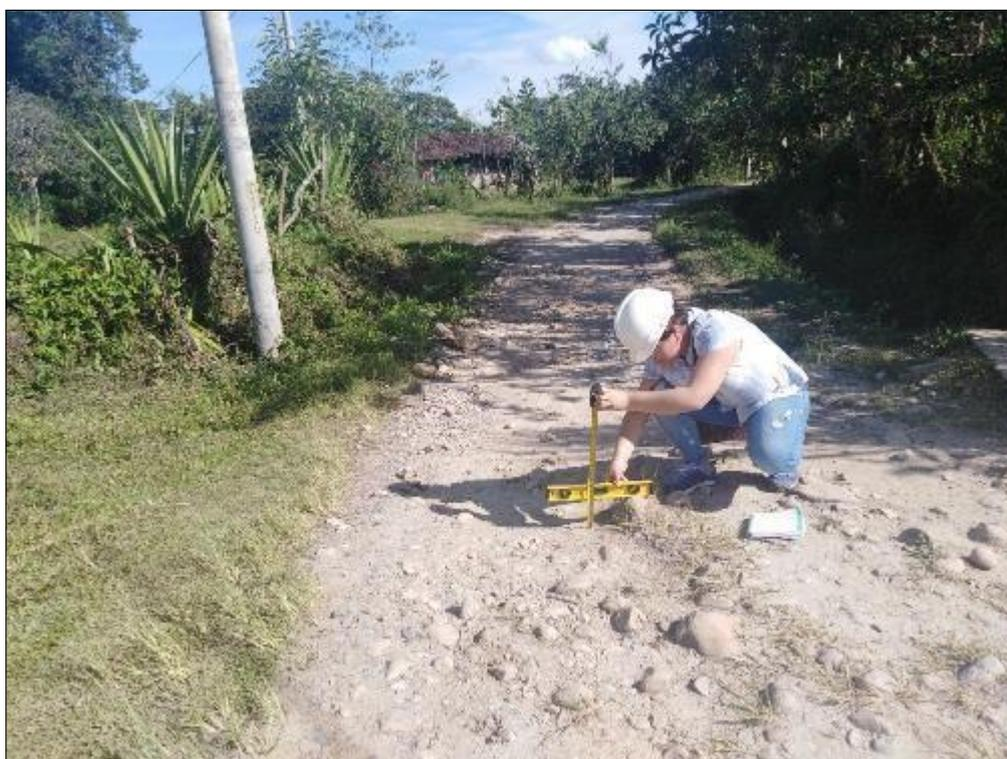
Fotografía 18. Medición de falla por erosión – Tramo IV
