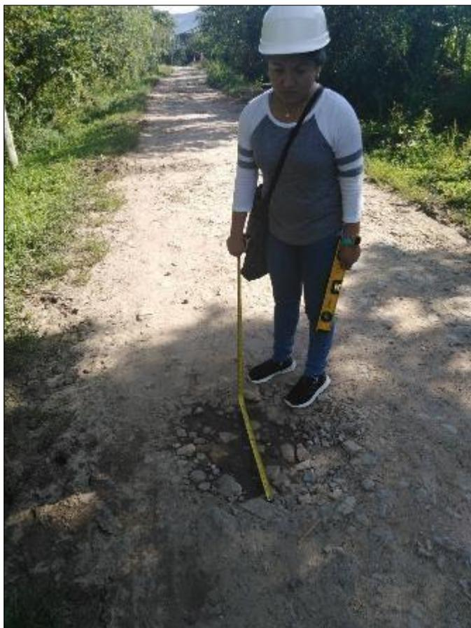
Fotografía 13. Medición de falla por baches – Tramo III
