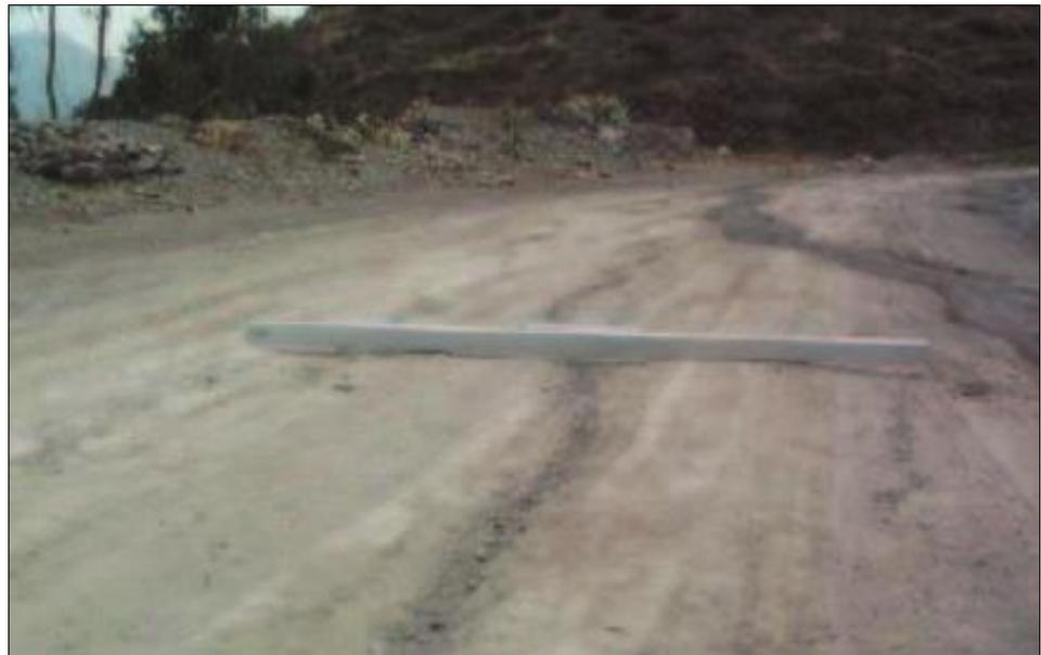
*Figura 4. Erosión Gravedad I - Sensible al usuario, pero < 5 cm*
