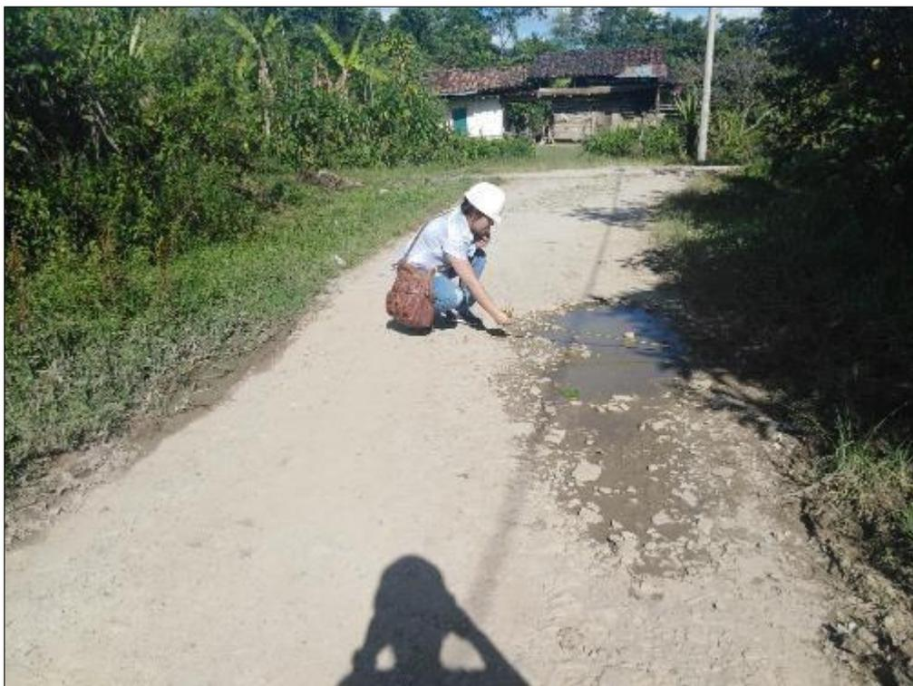
Fotografía 17. Medición de falla por baches – Tramo IV
