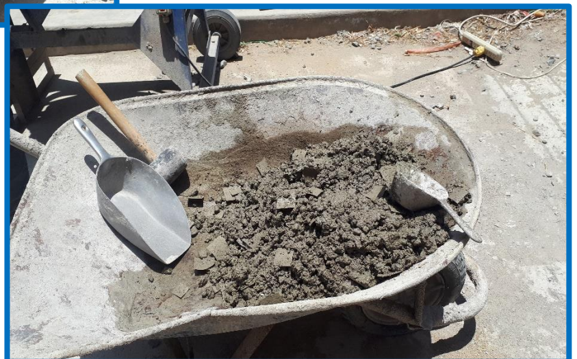
Foto N.º 45.- Mezcla de concreto para posterior colocación en testigos
