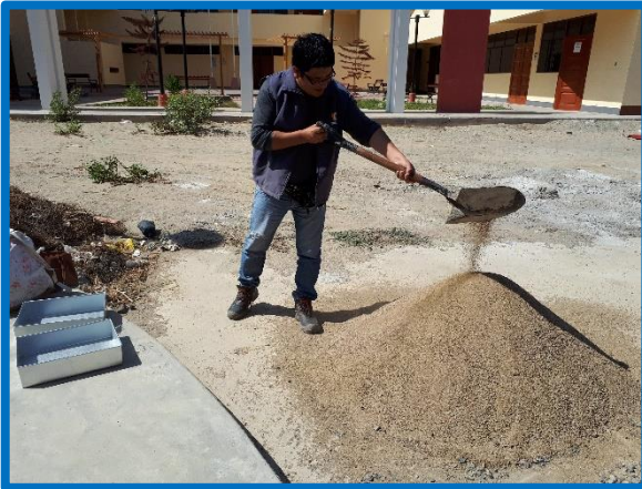
Foto N.º 05. -Mezcla del material agregado grueso y fino previo a sacar la muestra para el diseño de mezcla.
