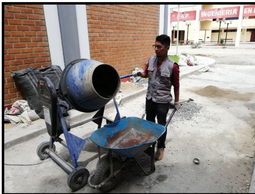
SATURACION DEL TROMPO ANTES DE AÑADIR LOS AGREGADOS
