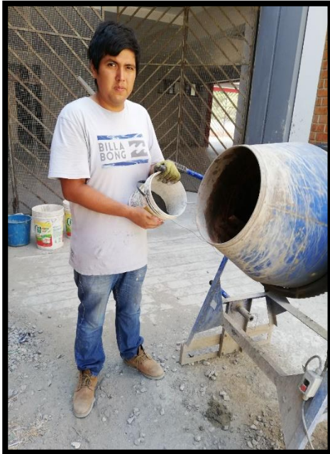
AÑADIENDO LA CENIZA VOLANTE Y METACAOLIN AL TROMPO PARA LA ELABORACION DE LA MEZCLA DE
