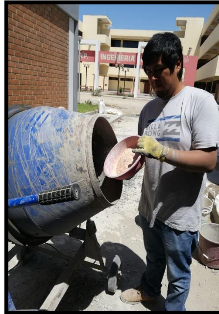
AÑADIENDO LA CENIZA VOLANTE Y METACAOLIN AL TROMPO PARA LA ELABORACION DE LA MEZCLA DE
