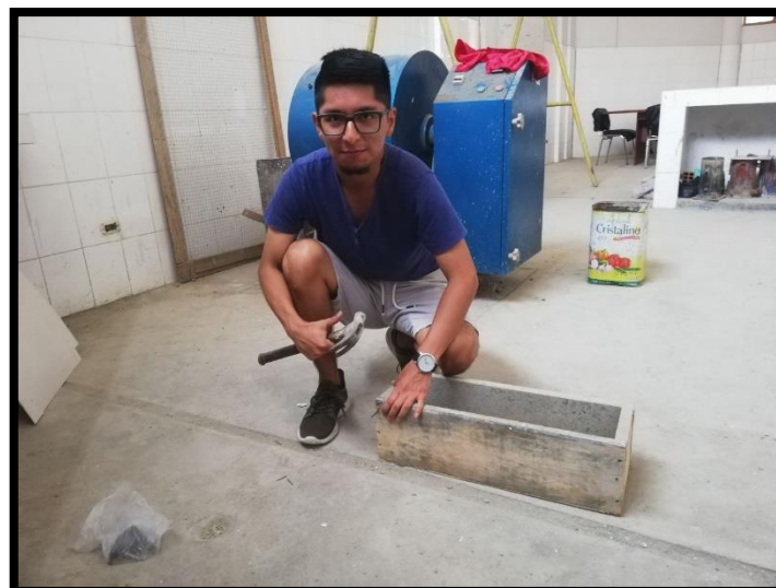
ARMADO DEL ENCOFRADOS PARA LAS VIGAS
