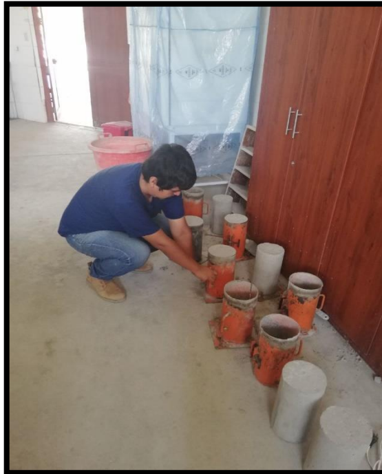
DESENCOFRADO DE LAS PROBETAS PARA SU POSTERIOR CURADO
