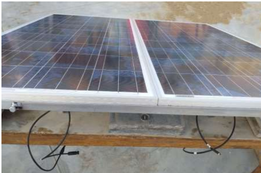
Figura 24: Primer día de Medición Módulos Fotovoltaicos.
