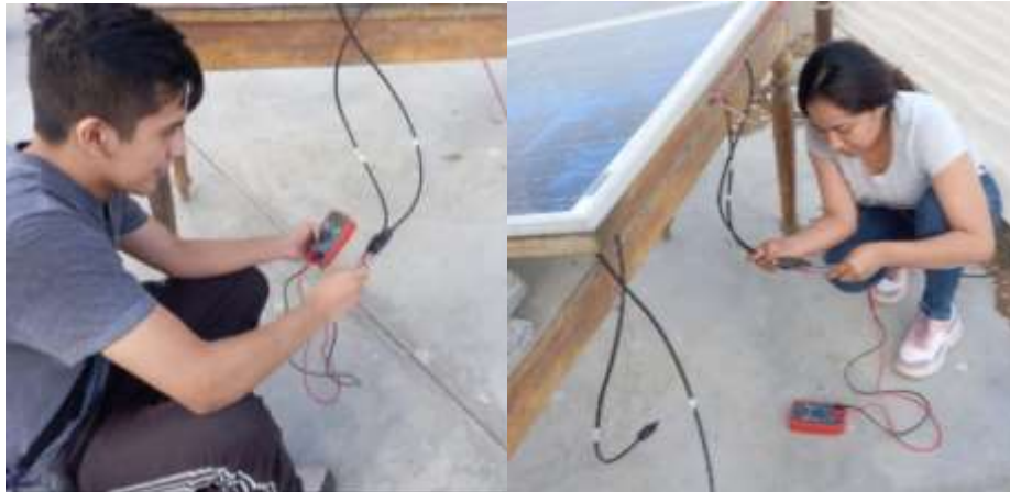
Figura 12: Medición de Voltaje e Intensidad de corriente.
