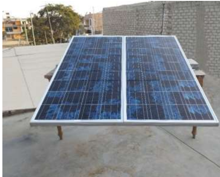
Figura 15: Instalación de los módulos Fotovoltaicos.
