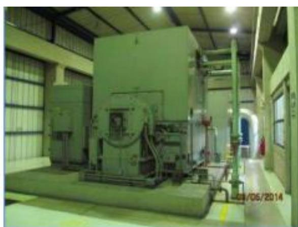
Figura 21 Turbina de vapor de central de biomasa con bagazo Paramonga
