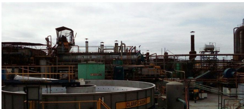
Figura N° 18 Vista de Planta Industrial de Empresa Centinela
