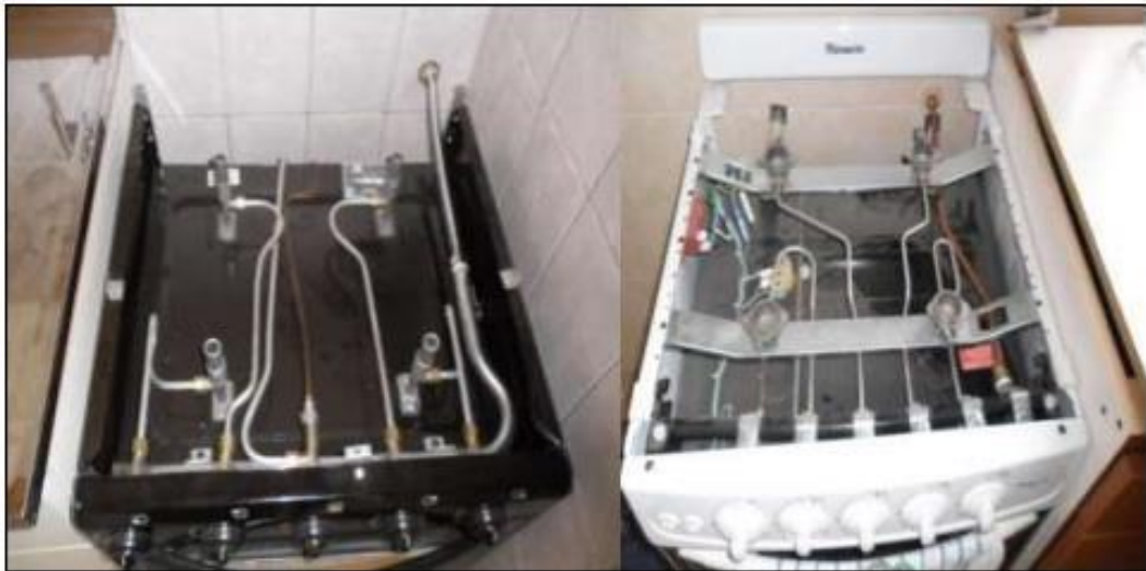
Figura 12 Cambio de inyectores en cocina
