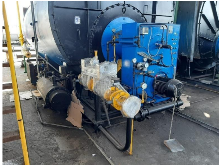
Figura 11 Proceso de reconversión de caldera pirotubular en Chimbote
