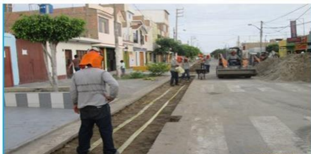
Figura 07 Instalación de redes de distribución de gas. Urb Trapecio
