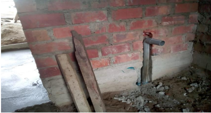
FOTO N°16 se observa el punto de salida de la instalación sanitaria del lavadero en cocina
