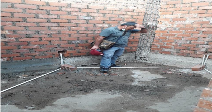
FOTO N°13 se observa los trabajos de nivelación y limpieza del terreno y la colocación de las instalaciones eléctricas en tomacorrientes para luego colocar el falso piso.
