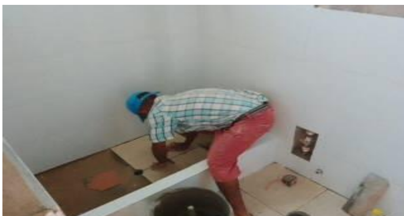
FOTO N°43 se observa la de colocación del acabado con cerámico en la ducha del baño
