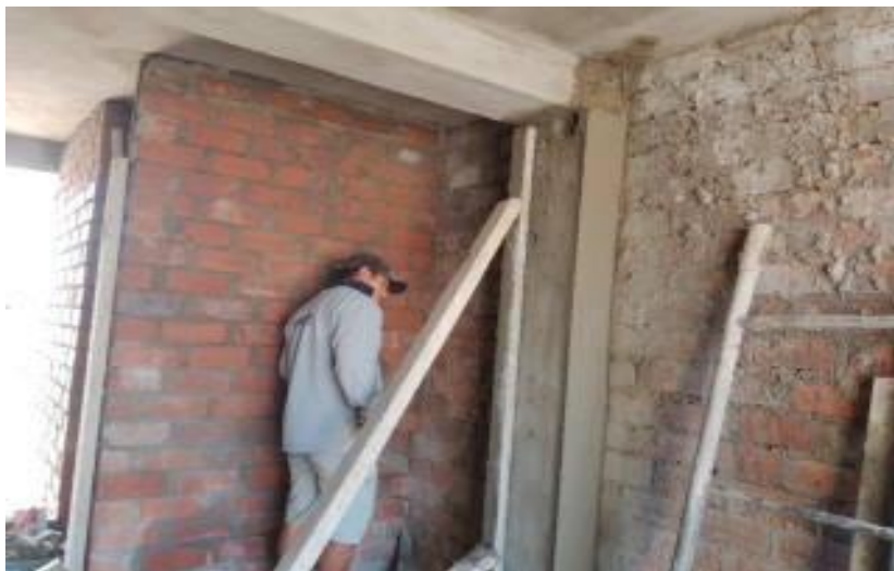
FOTO N°30 se observa el tarrajeo de las superficie y aristas de columna
