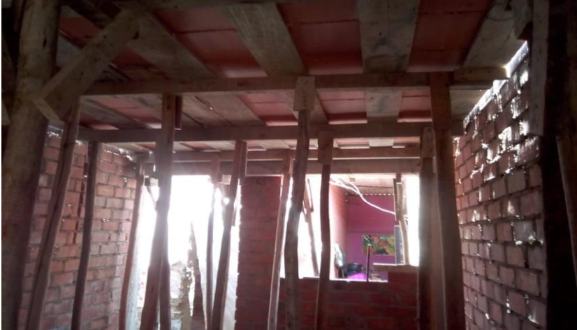
FOTO N°22 se observa los pies derechos del encofrado de la loza aligerada
