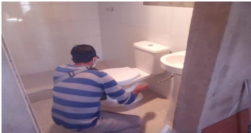
FOTO N°42 se observa el acabado con ceramica y los accesorios del baño inodoro y lavadero en el baño
