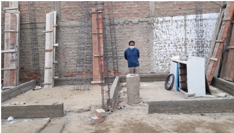
FOTO N°05 se observa los trabajos de sobrecimiento ya vaciado y desencofrado ya listo para comenzar con el asentado de ladrillos en muros
