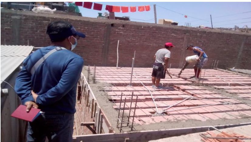
FOTO N°24 se observa el vaciado de concreto en loza aligerada
