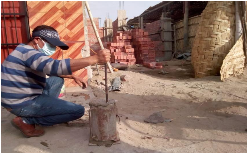
FOTO N°47 se observa la toma de muestras de probeta para ver la reistencia del concreto
