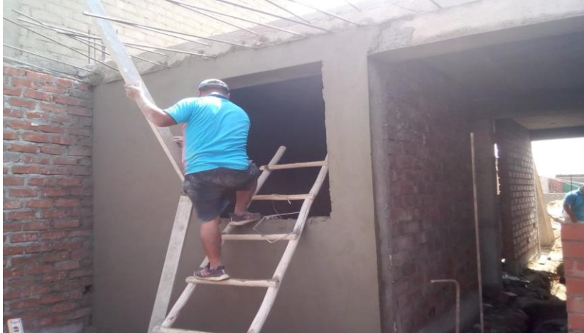
FOTO N°39 se observa el tarrajeo de la fachada del modulo de vivienda
