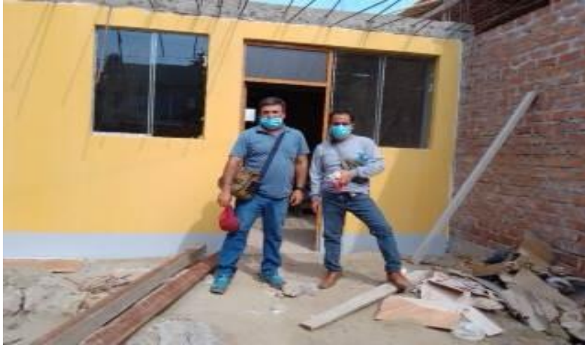
FOTO N°51 se observa los tesístas en uno de los modulos ya terminados
