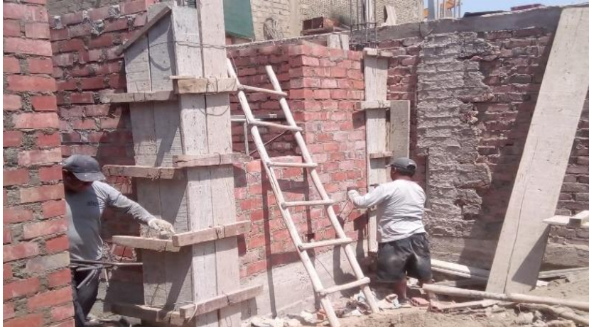
FOTO N°10 se observa los trabajos de encofrado de columnas
