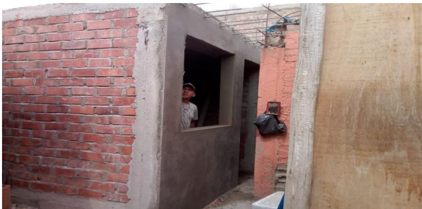
FOTO N°50 se observa la fachada del modulo de vivienda
