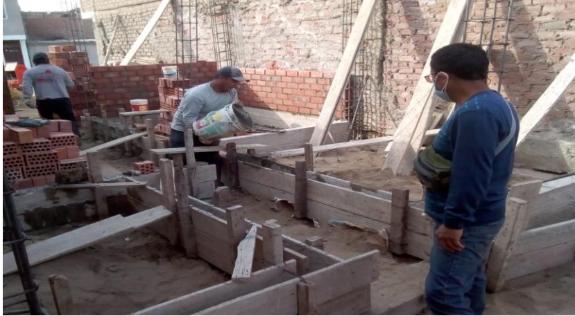
FOTO N°07 se observa el sobrecimiento ya emcofrado y el vaciado para comenzar con el asentado de ladrillo en muro
