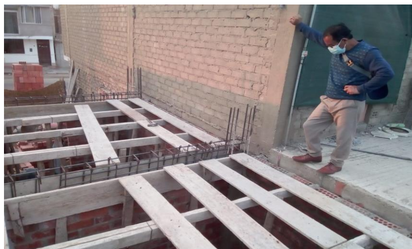
FOTO N°20 se observa la colocación de tablas en el encofrado de loza aligerada
