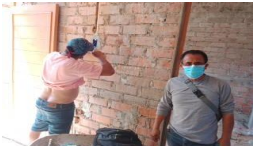
FOTO N°31 se observa los trabajos de instalación eléctricas en interruptores
