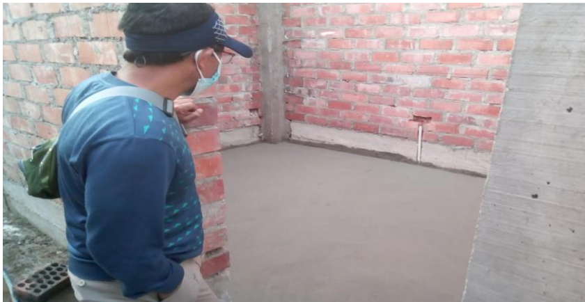
FOTO N°14 se observa el falso piso ya vaciado y la instalación de tomacorriente
