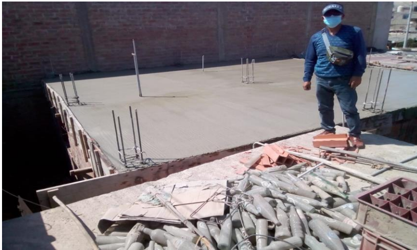
FOTO N°26 se observa la loza aligerada ya terminada de vaciado de concreto
