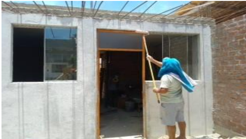
FOTO N°49 se observa el pintado de la fachada del modulo de vivienda
