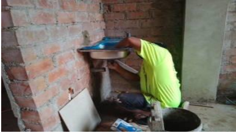
FOTO N°45 se observa la colocación de lavadero en cocina
