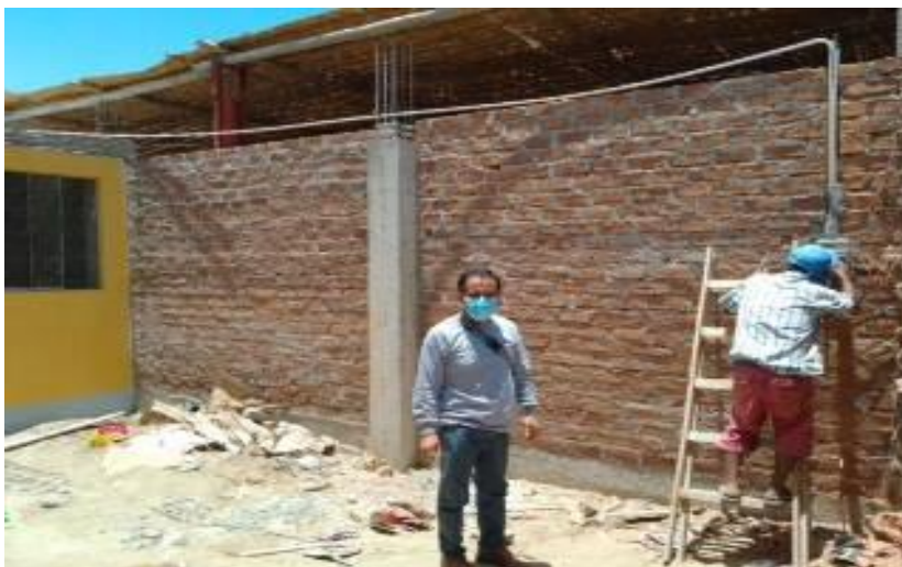
FOTO N°35 se observa la colocación de artefacto de tablero general en instalación eléctrica
