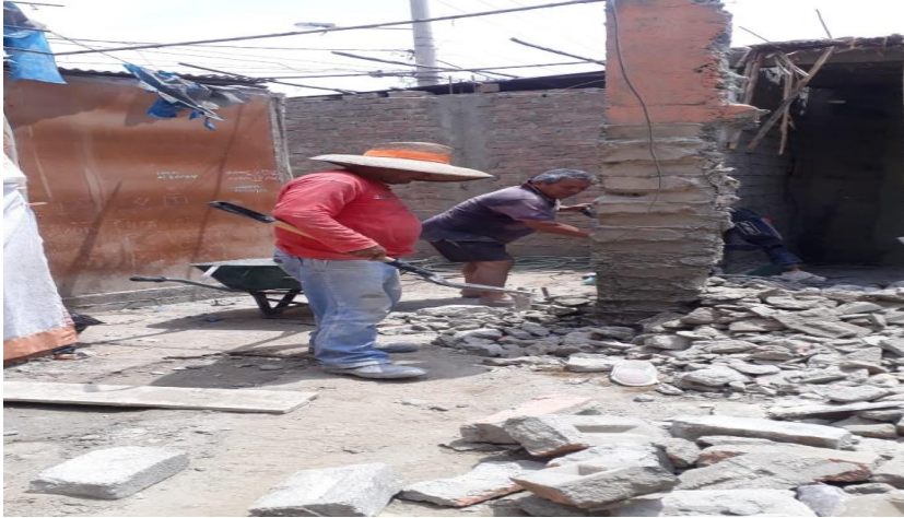
FOTO N°01 se observa los trabajos de demolición de construcciones antiguas para comenzar con los trazos y nivelación del terreno
