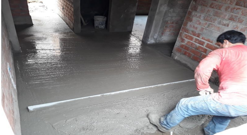
FOTO N°36 se observa el vaciado y reglado del concreto del falzo piso en el área de la sala
