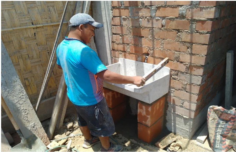
FOTO N°17 se observa la instalación del lavadero en la parte posterior
