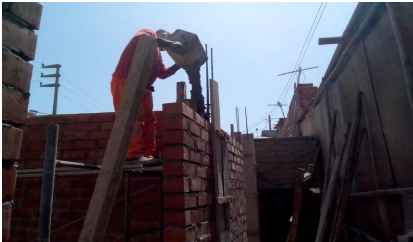
FOTO N°11 se observa los trabajos de vaciado de concreto en columna
