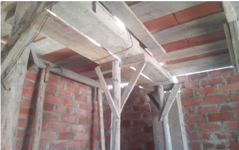
FOTO N°23 se observa el encofrado de la viga peraltada
