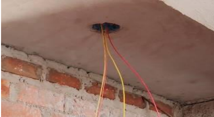
FOTO N°33 se observa los trabajos de cableado en instalación eléctrica del alumbrado
