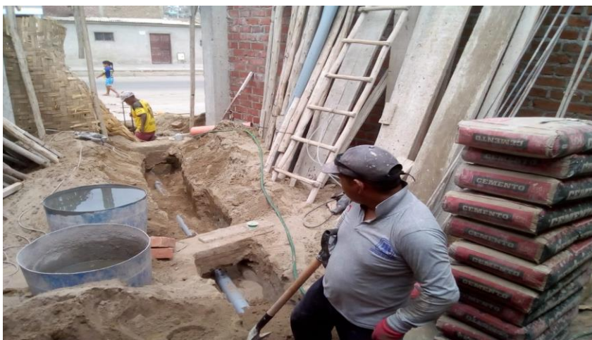
FOTO N°15 se observa los trabajos de colocación en zanja de tubería pvc de 4” para la instalación sanitaria (desague)
