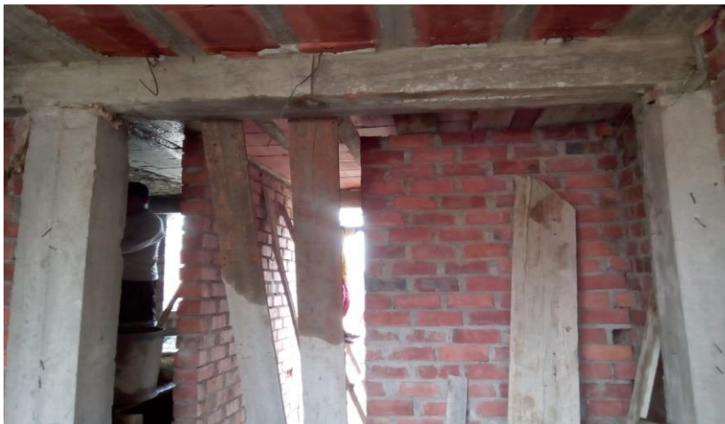
FOTO N°27 se observa la viga peraltada ya vaciada de concreto y desencofrada
