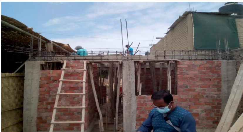
FOTO N°19 se observa la colocación del acero en viga
