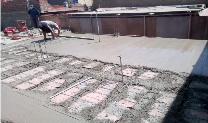
FOTO N°25 se observa el vaciado y regleado de concreto en loza aligerada
