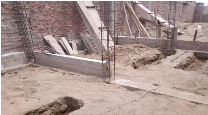
FOTO N°06 se observa el sobrecimiento y viga de cimentacion, ya vaciado y desencofrado listo para comenzar con el asentado de ladrillos en muros en el sobrecimiento
