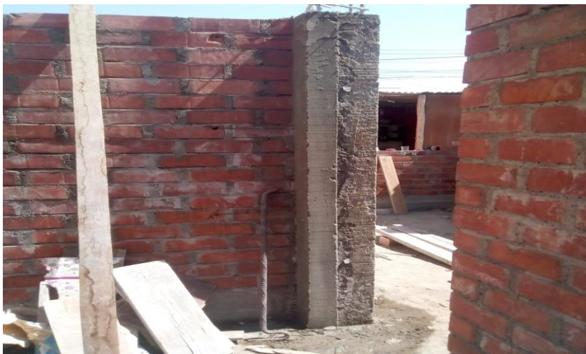
FOTO N°12 se observa las columnas ya desencofradas
