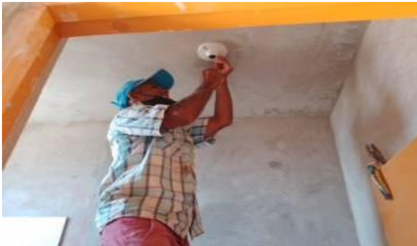
FOTO N°34 se observa la colocación de artefacto de alumbrado en instalación eléctrica
