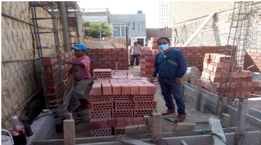
FOTO N°08 se observa los trabajos de asentado de ladrillo en muro
