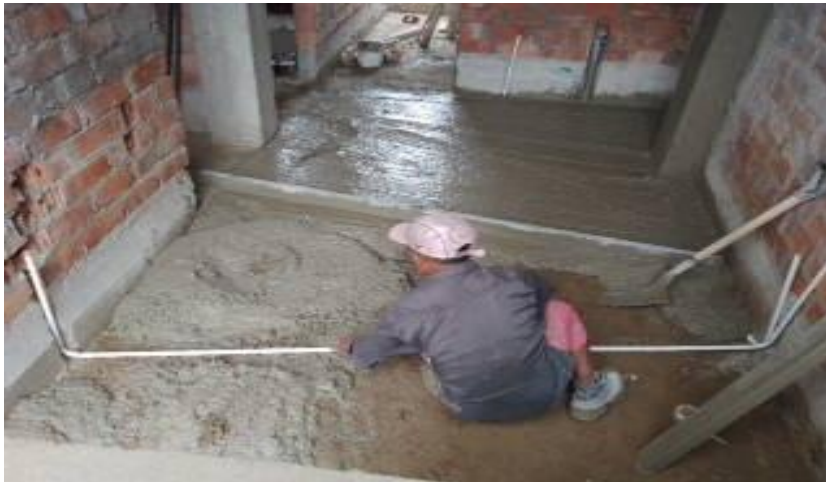
FOTO N°37 se observa el vaciado y reglado del concreto del falzo piso en el área de la sala
