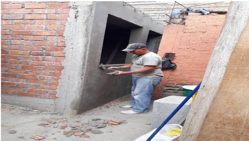
FOTO N°40 se observa el tarrajeo de la fachada del modulo de vivienda
