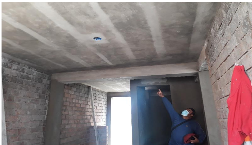
FOTO N°29 se observa el cielo raso ya terminado en el área de la sala y comedor
