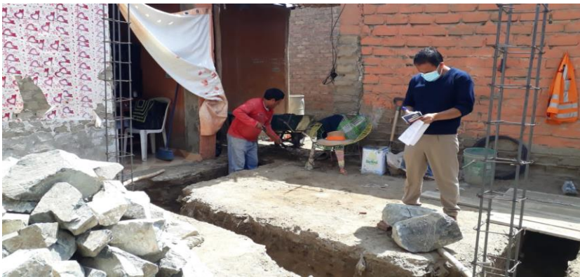
FOTO N°02 se observa los trabajos de excavación de zanja para cimiento corrido
