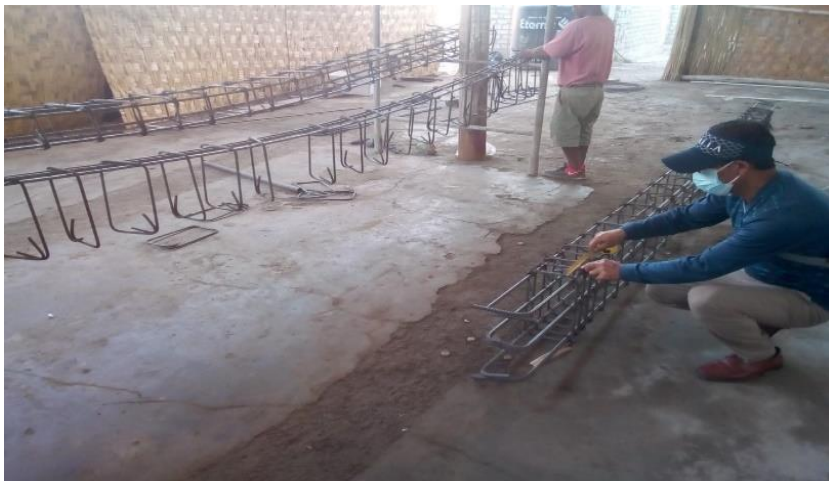
FOTO N°18 se observa los trabajos de habilitación del acero en viga peraltada
