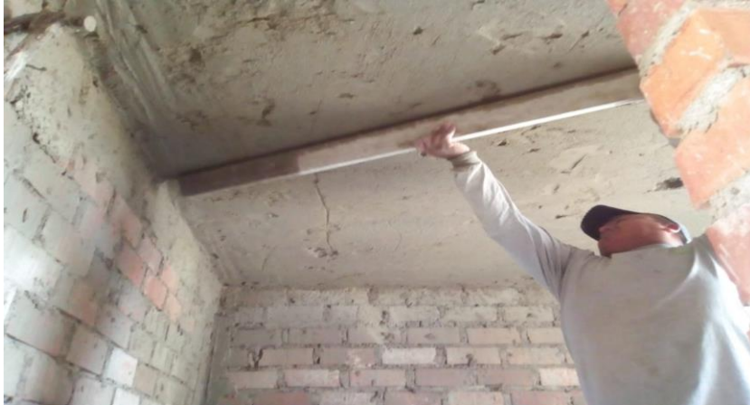
FOTO N°28 se observa los trabajos de colocación de cielo raso
