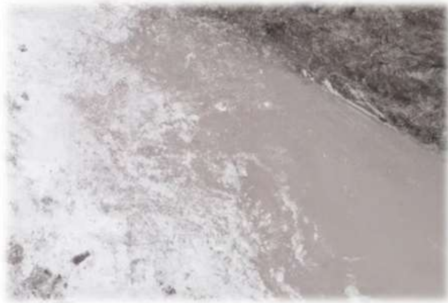
Figura 9. Exudación del concreto.
