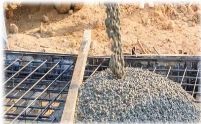
Figura 2. Concreto estructural en cimentación.
