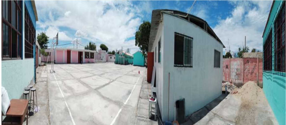
FOTO N° 03: VISTA PANORÁMICA INTERNA DE LA I.E. ERASMO ROCA
