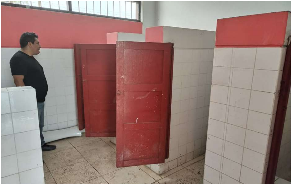
FOTO N° 08: REVISANDO EL SISTEMA DE AGUA Y ALCANTARILLADO EN S.S.H.H. EN DAMAS
