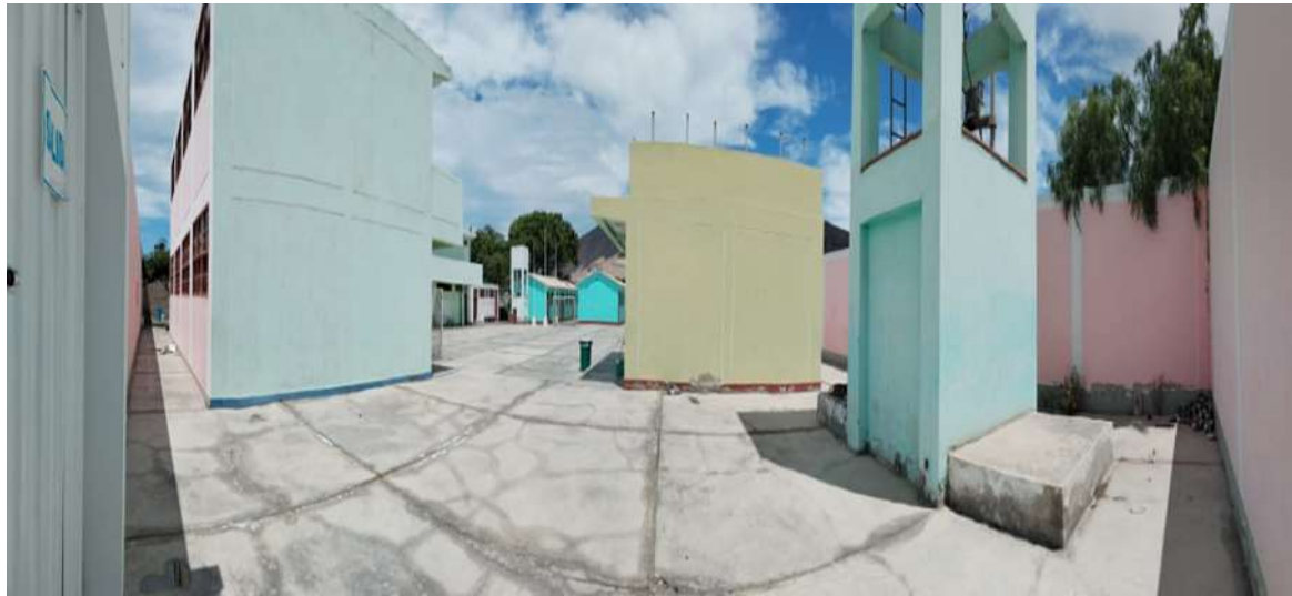
FOTO N° 05: PANARÁMICO DEL TANQUE ELEVADO Y S.S.H.H. FUNCIONALES
