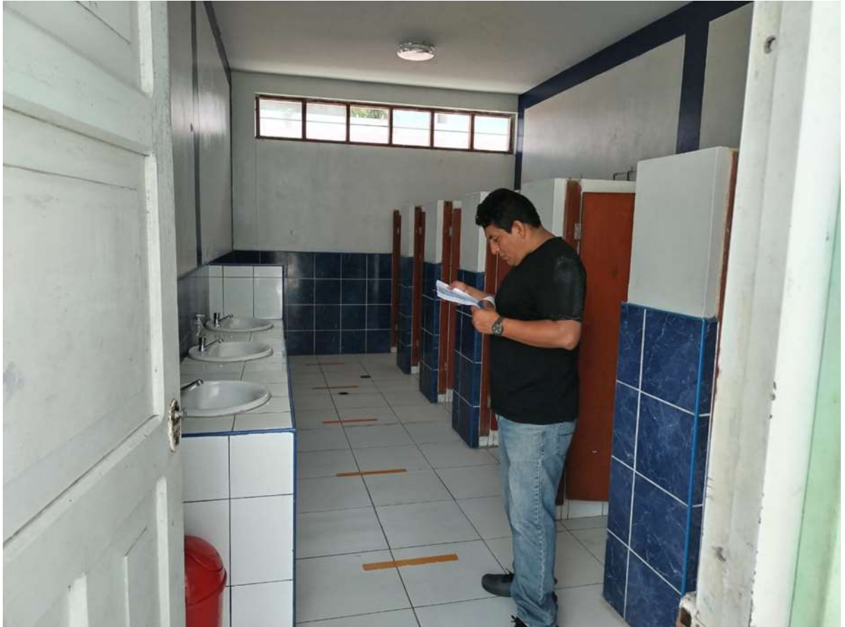
FOTO N° 07: VERIFICANDO EL SISTEMA DE AGUA Y ALCANTARILLADO EN S.S.H.H. EN VARONES
