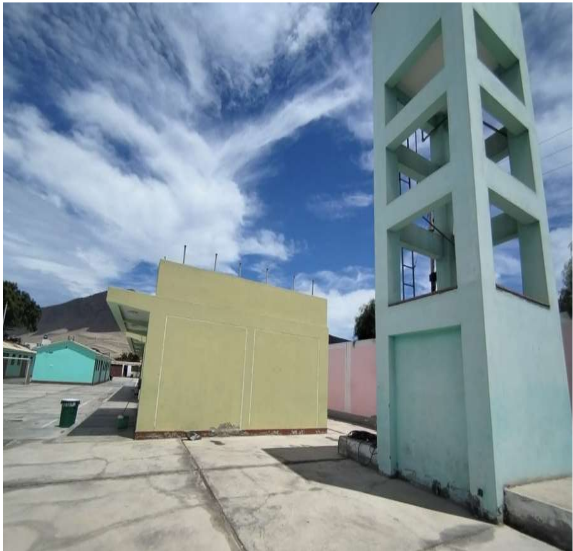
FOTO N° 04: VISTA DEL TANQUE ELEVADO FUNCIONAL
