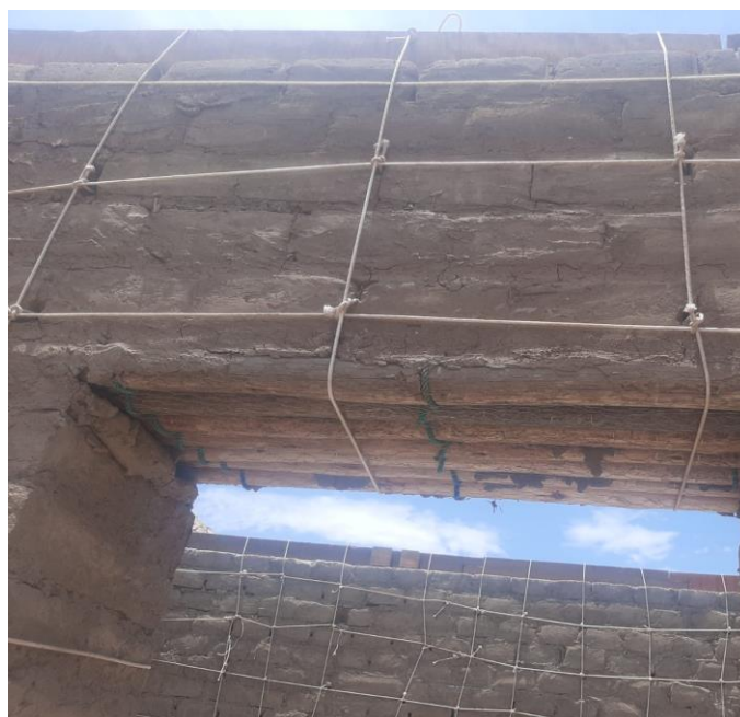
Foto 07: Colocación de rollizos de madera y drizas de plástico.
