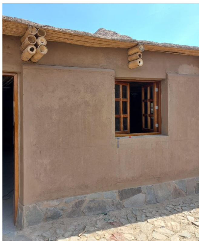
Foto 08: Acabado final de muro con tarrajeo de arcilla.
