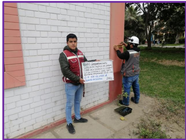
Foto N° 05: Scaneo de acero en columna previo a la extracción de testigos de concreto.
