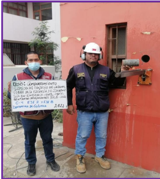
Foto N° 10: Extracción de testigos de concreto en columna C-4, modulo I.
