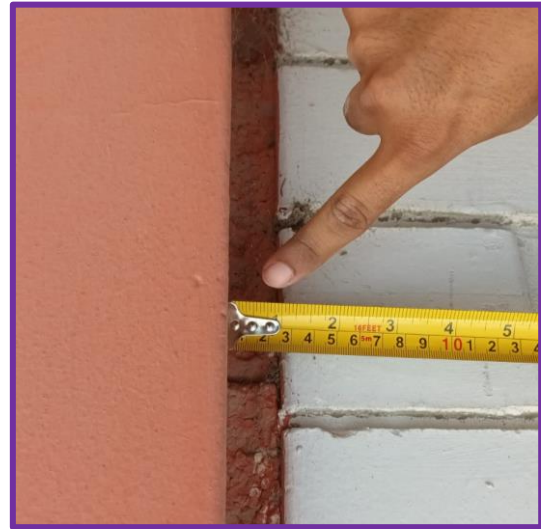
Foto N° 01: Medición de juntas de dilatación entre muro y columnas (exteriores).
