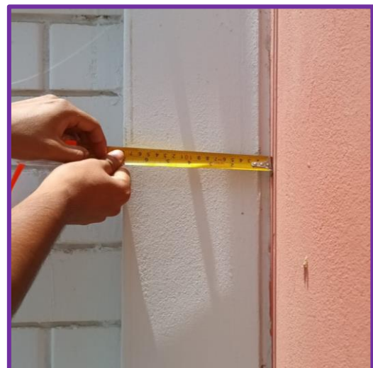
Foto N° 03: Medición de juntas de dilatación entre alfeizar y columnas (exteriores).
