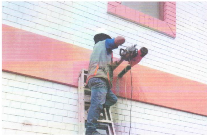
Ensayos de extracción de núcleos de concreto con maquina diamantina en columnas y vigas
