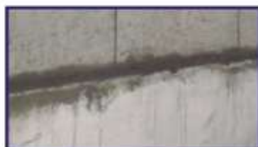
Nivelamiento primera hilada
