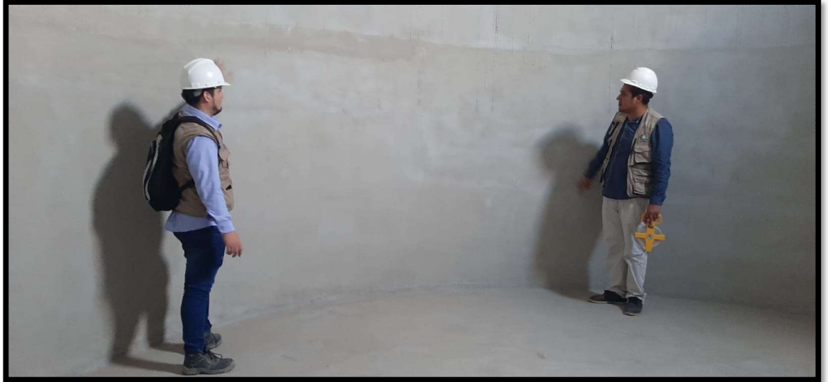
Foto 09: Inspección visual por dentro del reservorio
