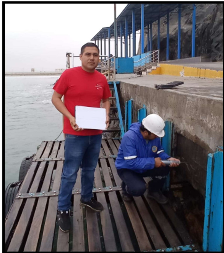
Foto 20: Ensayo no destructivo de esclerometría para estimar la resistencia del concreto en la unidad muestral más crítica en el muelle
