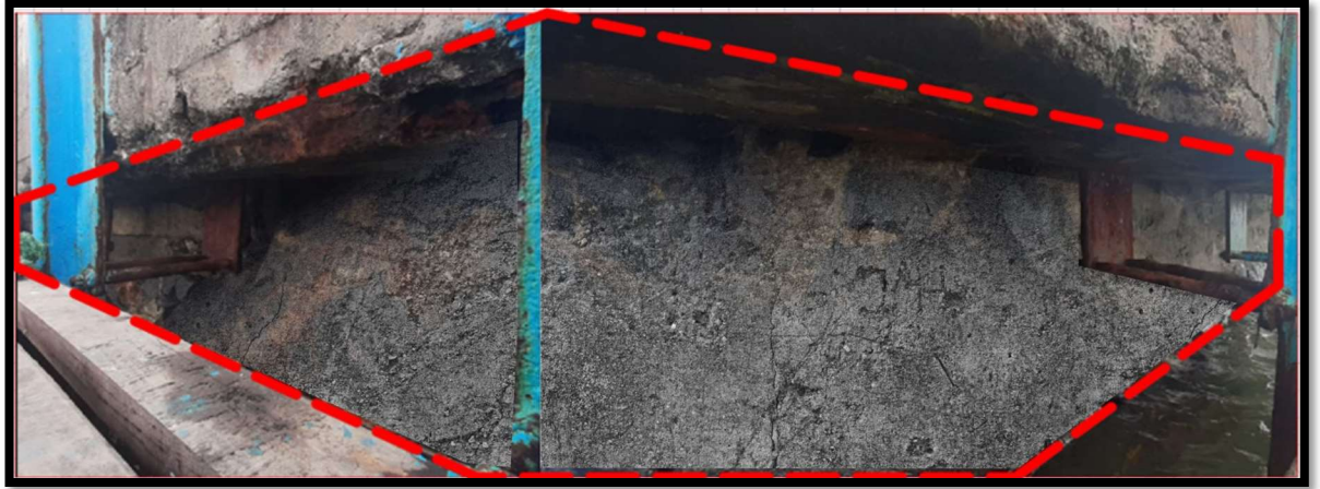
Foto 19: Toma de datos de patologías identificadas
