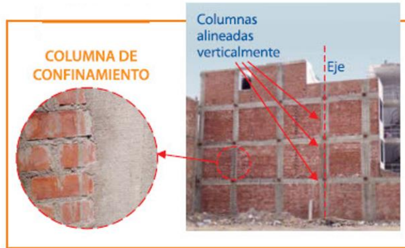
Figura 23 Columnas de confinamiento alineadas verticalmente.
