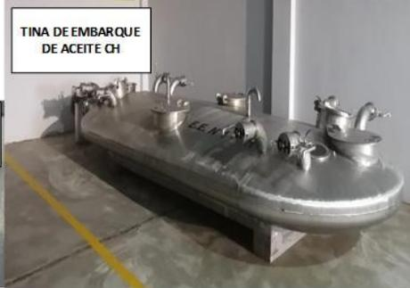
Implementación de tanques de almacenamiento de material inoxidable en la planta de refinación
