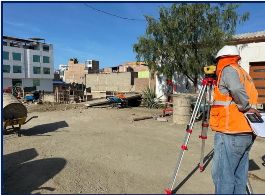
***DESCRIPCIÓN: Se observa el trazo y replanteo de los niveles del Muro de Contención.***
