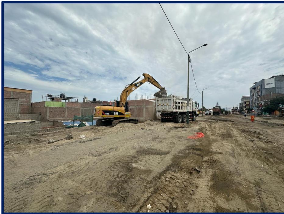
***DESCRIPCIÓN: Se muestra en las tomas el corte hasta nivel de subrasante para el muro de Contención.***
