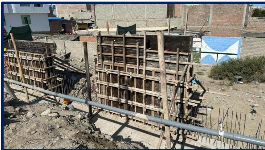
**DESCRIPCIÓN:** *Se muestra el encofrado de la zapata del Muro de Contención 01.*
