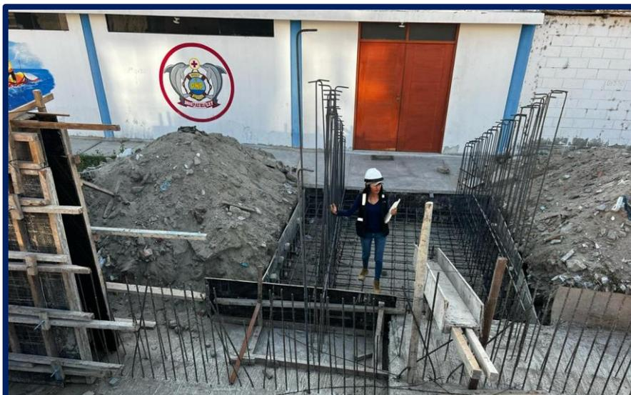
**DESCRIPCIÓN:** En las tomas se muestra el llenado de concreto  $f'c=210$  kg/cm<sup>2</sup> de la zapata del Muro de Contención.
