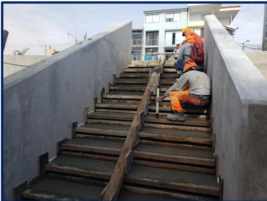
**DESCRIPCIÓN:** Se observa el vaciado de concreto  $f'c=210\text{kg/cm}^2$  de las gradas, entre el Muro 01 y el Muro 02.
