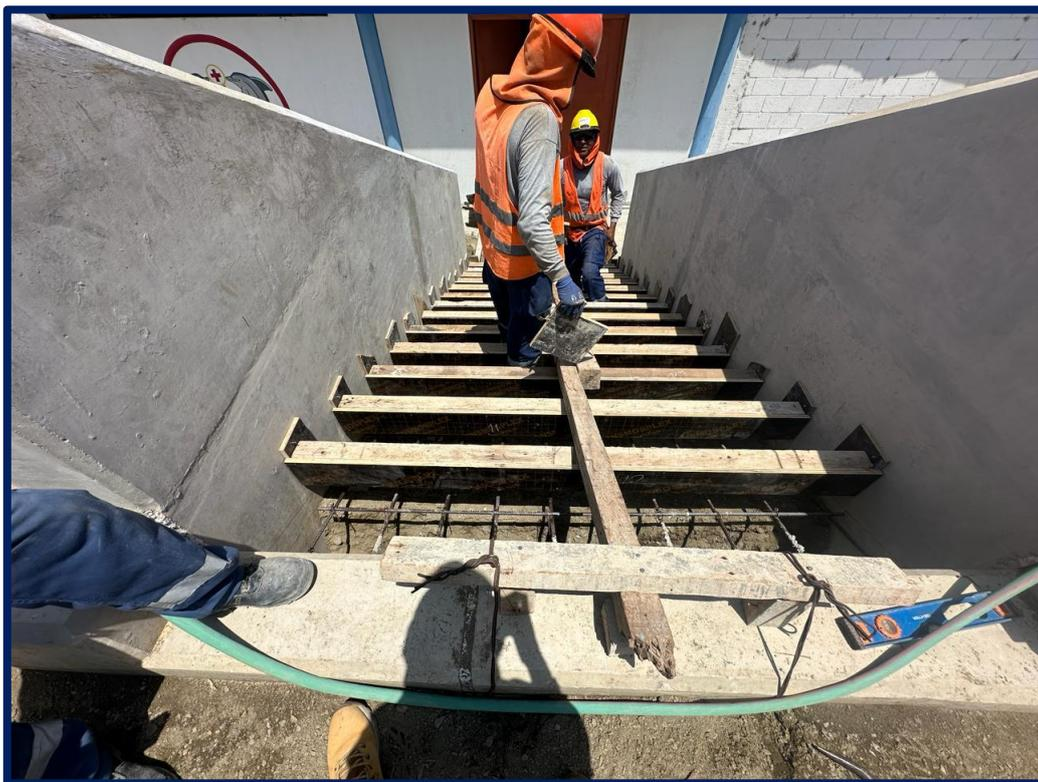
**DESCRIPCIÓN:** Se observa en la toma fotográfica el encofrado de las gradas del muro de contención
