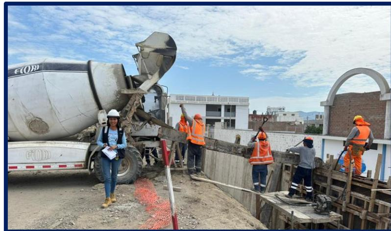
**DESCRIPCIÓN:** En las tomas se muestra el llenado de concreto  $f'c=210$  kg/cm<sup>2</sup> de la zapata y pantallas de los Muros de Contención.
