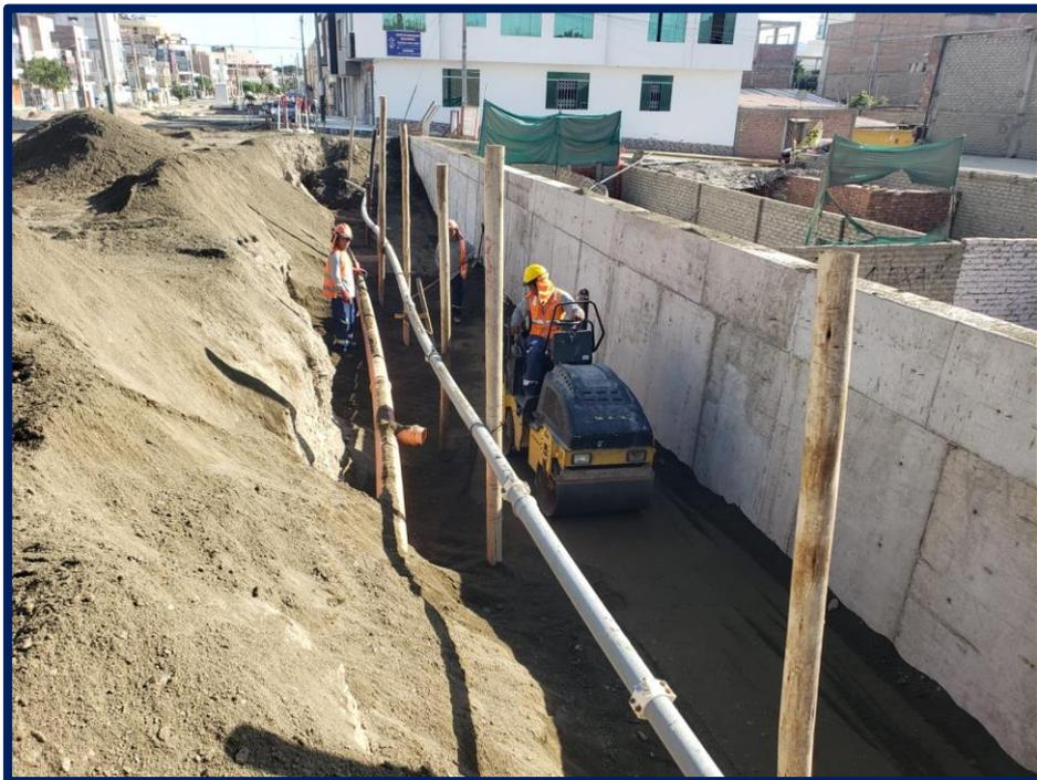
**DESCRIPCIÓN:** *Se muestra en las tomas fotográficas el relleno y compactación con material de préstamo en el Muro 05*
