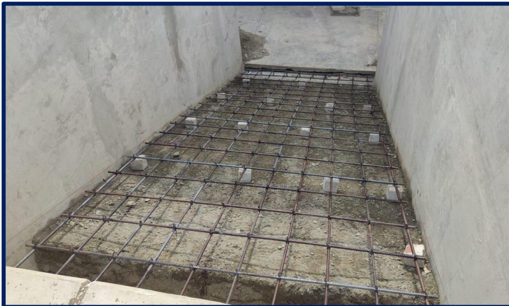
**DESCRIPCIÓN:** Se muestra en la toma la colocación del acero  $F_y=4,200\text{KG}/\text{CM}^2$  en gradas
