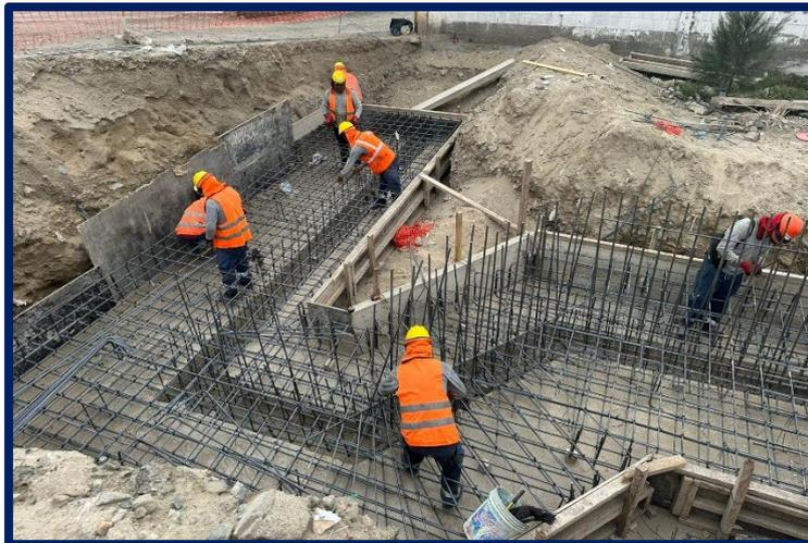
**DESCRIPCIÓN:** Se muestra la colocación de acero de la zapata y pantalla del Muro de Contención 01.
