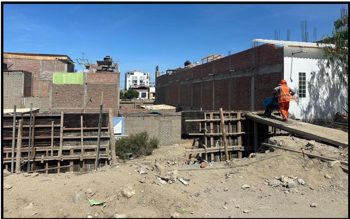
**DESCRIPCIÓN:** En las tomas se muestra el llenado de concreto  $f'c=210 \text{ kg/cm}^2$  de la zapata y pantallas de los Muros de Contención.
