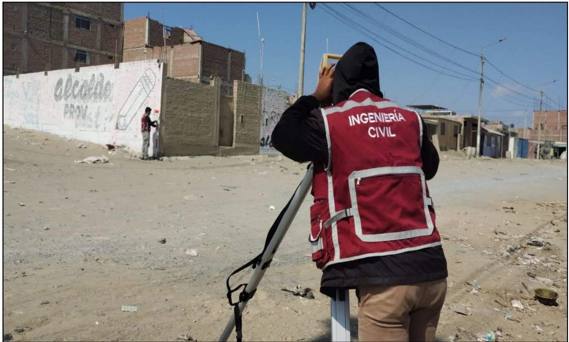
FOTO 4: Levantamiento topográfico en la zona de trabajo.
