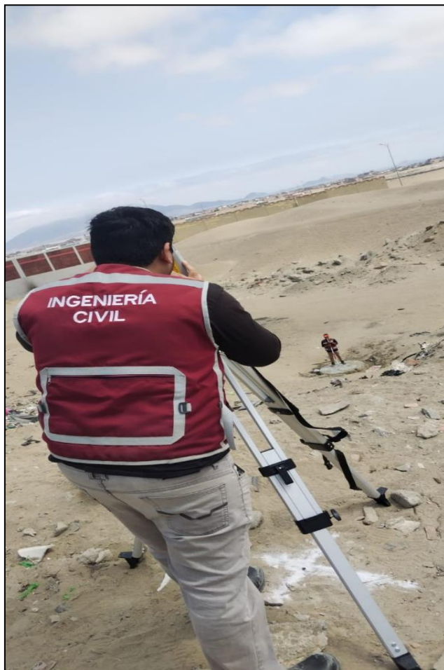
FOTO 8: Levantamiento topográfico en la zona de trabajo.
