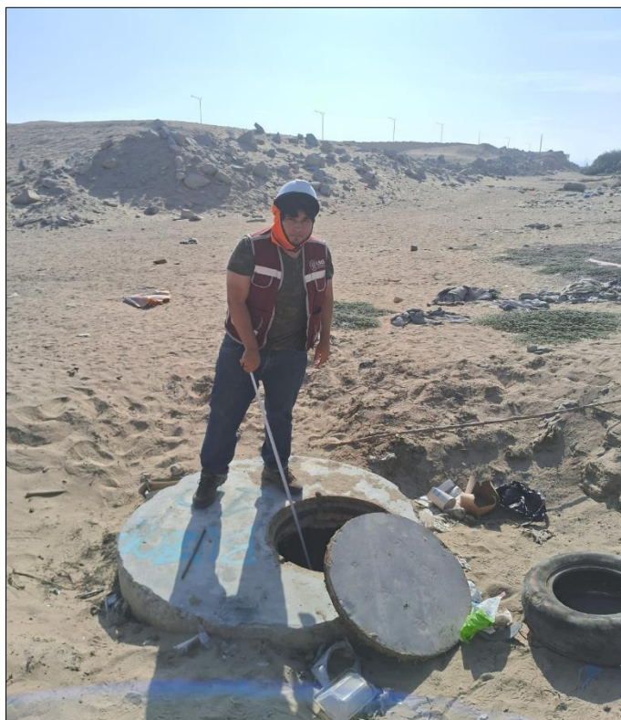
Figura 30. Buzón existente para empalme
