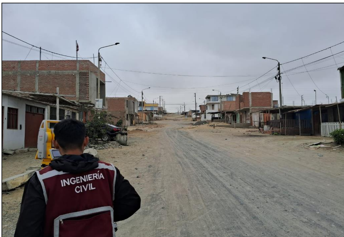
FOTO 7: Levantamiento topográfico en la zona de trabajo.
