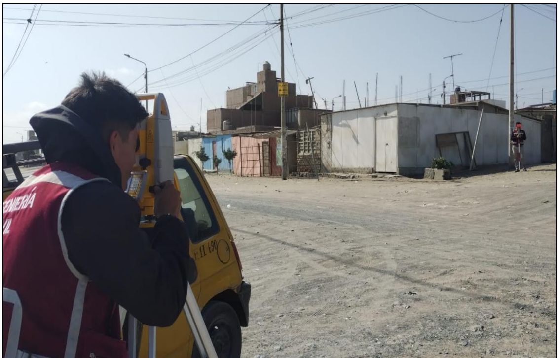
FOTO 5: Levantamiento topográfico en la zona de trabajo.
