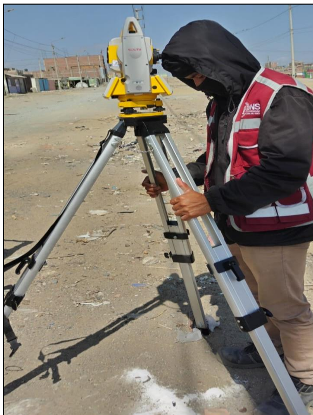
FOTO 2: Nivelación del equipo topográfico
