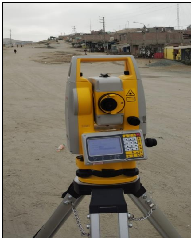
FOTO 1: Instalación del equipo topográfico
